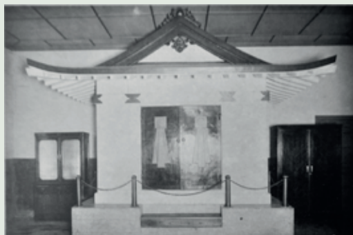
圖 6：昭和 14 年（1939）事務室內設置的奉安殿。
