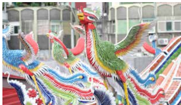
圖 5：修復工程在尊重原始材料為基礎下，盡可能保存和顯現古蹟建築的歷史與美學。（戴靜宜攝）
