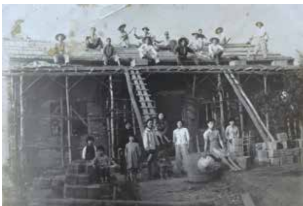
圖 5：徐明河與師傅及師兄弟在祖厝修復工程的現場合照，屋頂上方右 1 站立者為師傅姚自來，右 6 為徐明河。（徐明河提供）
