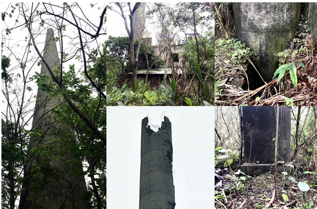
【左：協和磚廠煙囪；中上：協和磚廠辦公室；中下：煙囪頂端損毀；右上：煙囪抽風室；右下：煙囪底部煙道】
