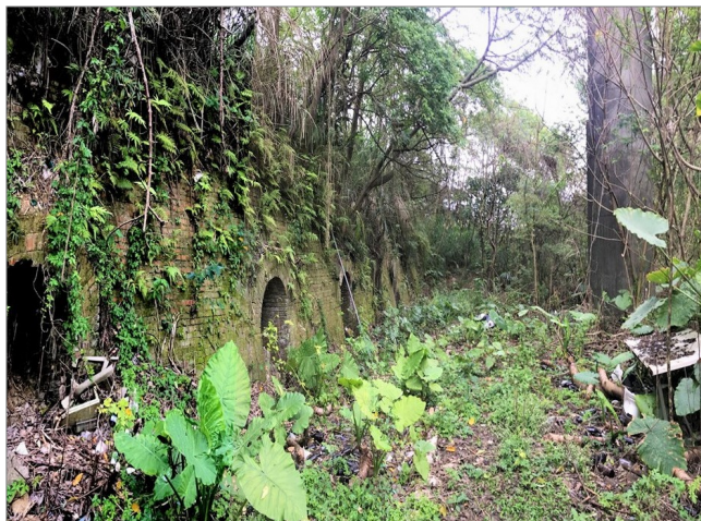
【龜山區的永基磚廠遺址】
