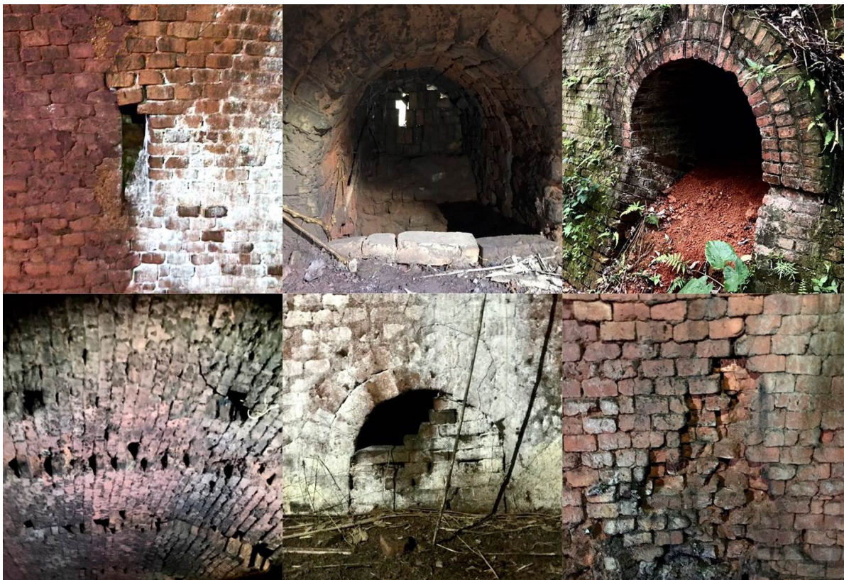
【協和磚廠窯室狀況】左上：煙孔；中上下：排灰孔；右上：窯門損耗；左下：窯頂送煤口；右下：窯室內牆
