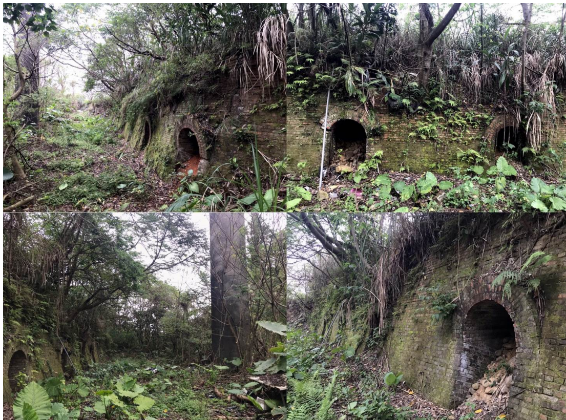
【上右\下右：永基磚廠遺構南側外牆；上左\下左：永基磚廠遺構外牆周邊與煙囪】
