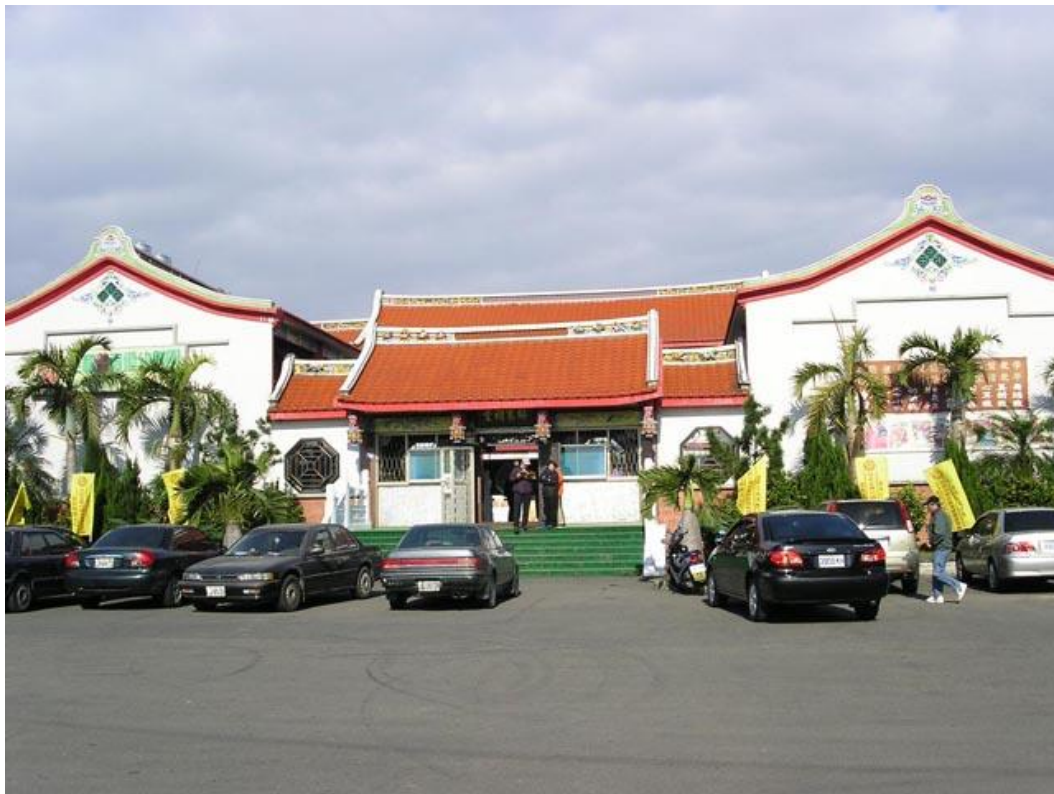
圖 2-5-3 大溪鎮丘家祠堂－忠實堂
