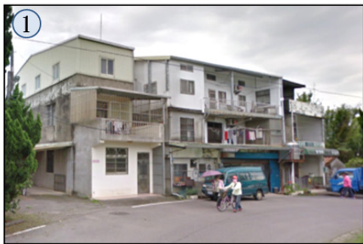
□ 公六用地既有建物現況
