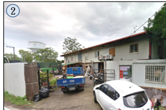
□ 公六用地既有建物現況
