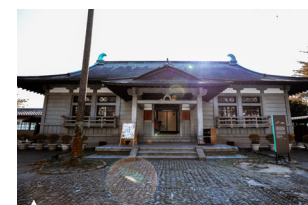
▲ 武德殿(公有館)
