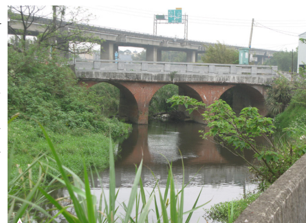
伯公潭紅磚糯米拱橋
