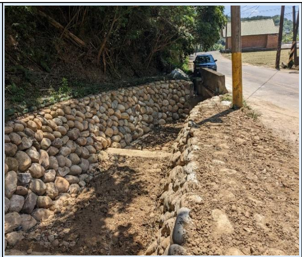
大溪區信義路 916 巷旁野溪治理工程
