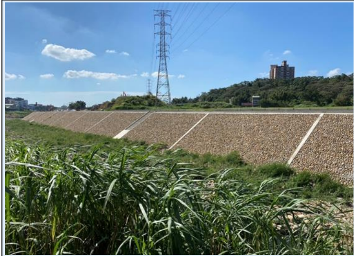
社子溪月眉橋下游至慈恩橋右岸護岸治理工程 (含慈恩橋改建)
