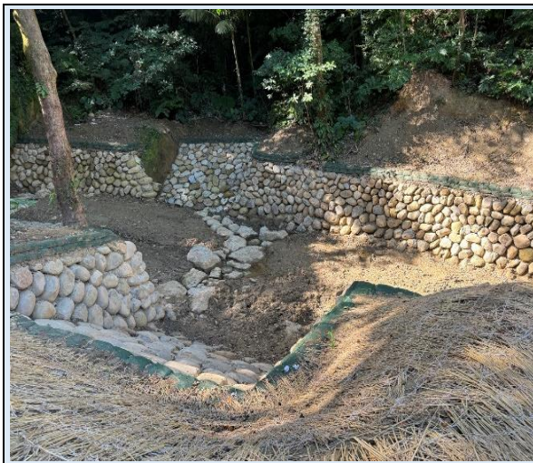
龜山區石雲路旁野溪整治工程
