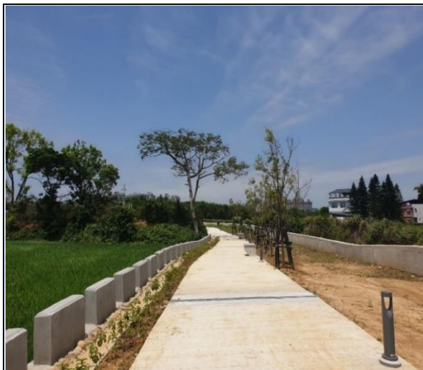
龍南幹線護岸整治完工照
