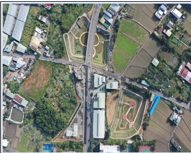
大樹林滯洪池(樹仁三街滯洪池工程)完工照
