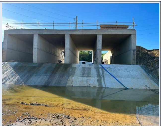
大仁滯洪池(員 74B 滯洪池工程)施工照
