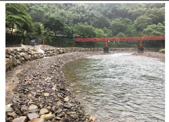
霞雲橋上游野溪清疏三期工程
