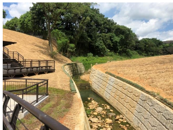
龜山區工四工業區旁野溪治理工程
