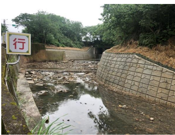
龜山區忠義路二段 118 巷 野溪災害防治工程
