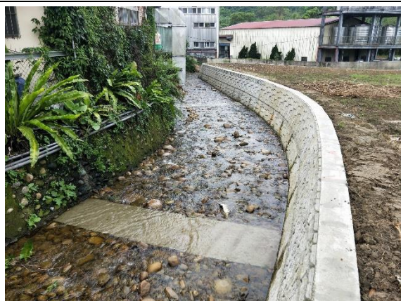
大溪區草嶺溪支流及 龍潭區台四線旁野溪治理工程
