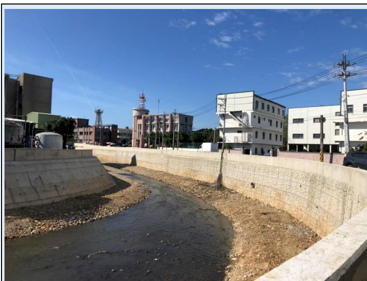
1090222 茄苳溪桃園大圳上游至成功橋段暨福豐橋 上游右岸護岸改善應急工程
