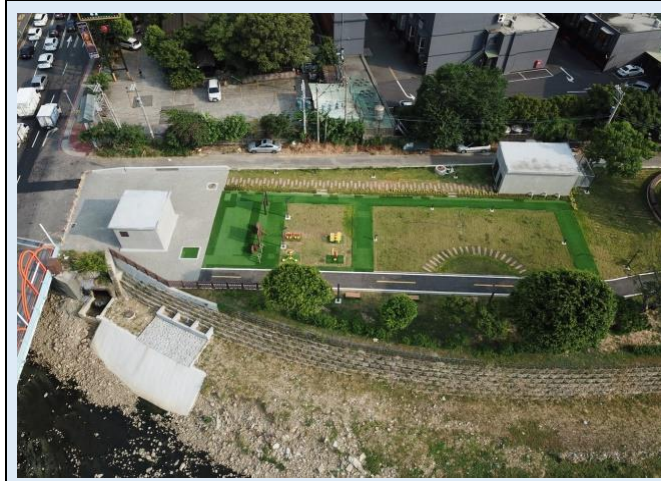
1090713 南崁溪水汴頭水質淨化現地處理工程 (空拍圖)
