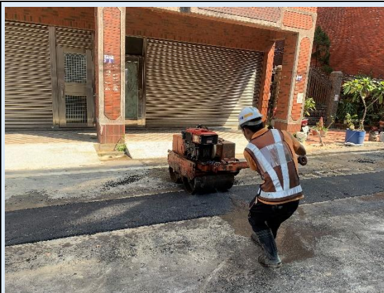
1090505 楊梅污水下水道第一期分支管及用戶接管工程完工道路回復
