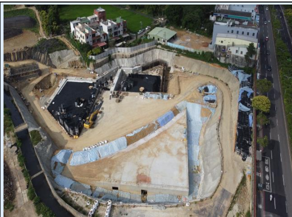
1100720 桃園區魚管處滯洪池(全景)
