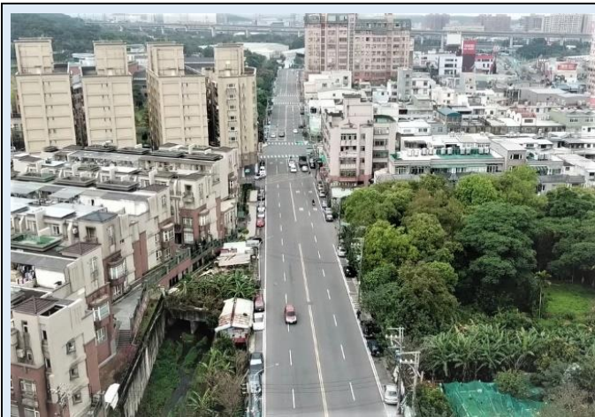
1100611 楊梅區瑞溪路雨水下水道工程
