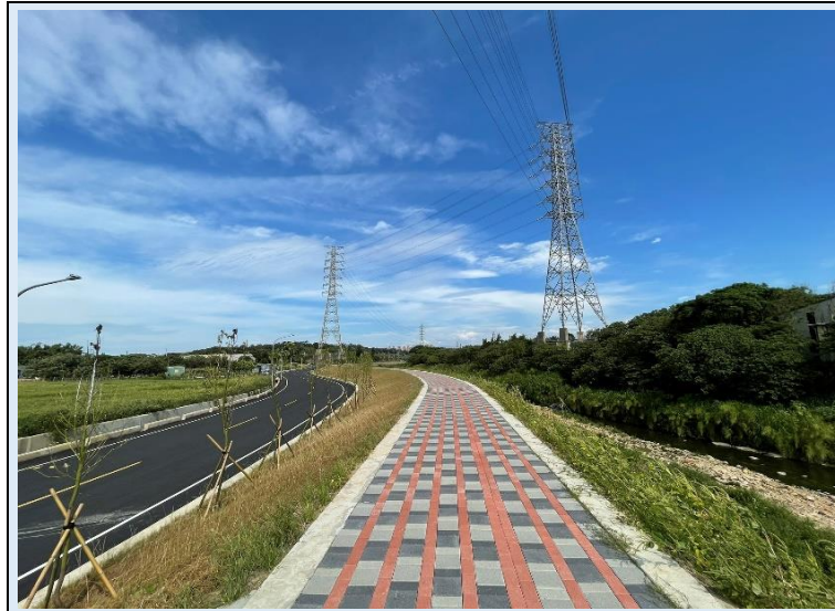
1100802 社子溪斷面 68 至 72-2D 護岸新建工程
