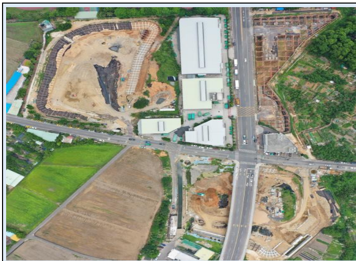
1100715 桃園區樹仁三街滯洪池(全景)
