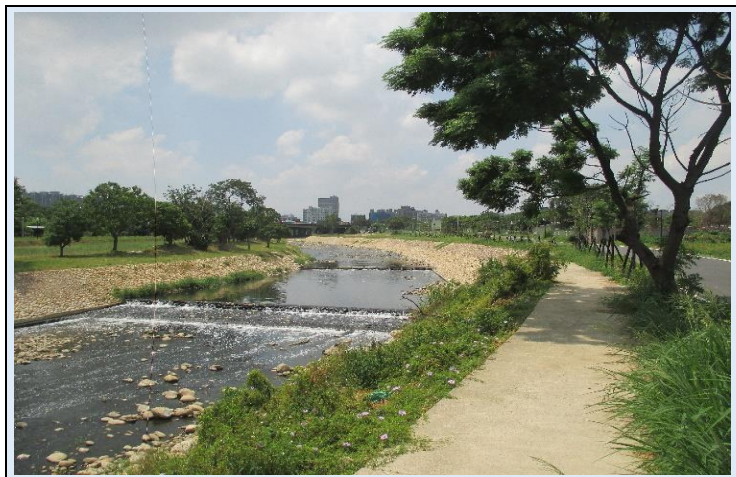
1100805 老街溪斷面 44 至斷面 46-1 堤防改善工程
