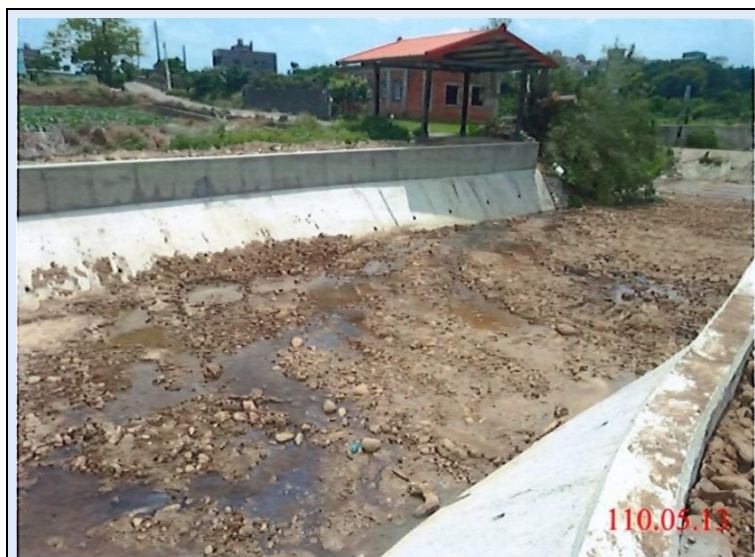
1100513 觀音溪莫內花園旁左右岸護岸修復工程
