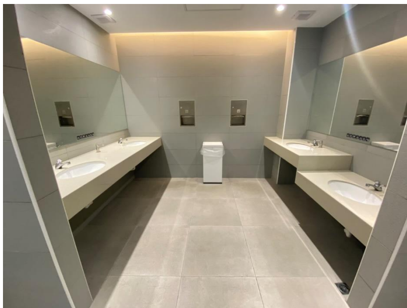
圖 2、本府市政大樓廁所洗手台
