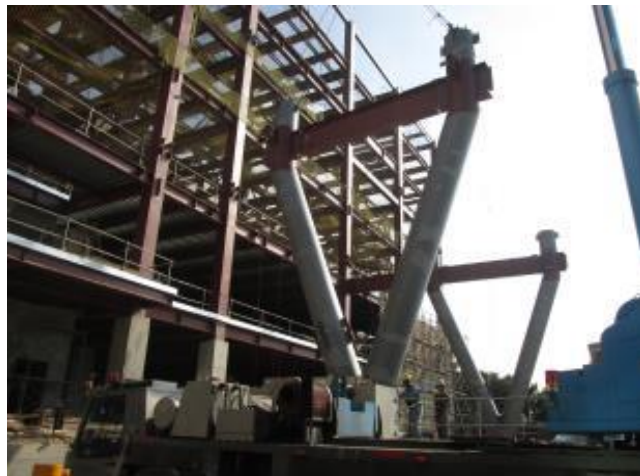
V型柱施工吊裝
