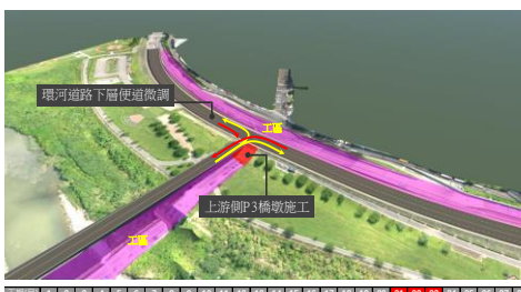
◆ 第二階段2-2項：施築上游側P3橋
