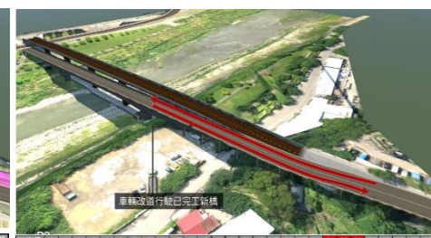
◆ 車輛改道行駛下游側已完工新橋
