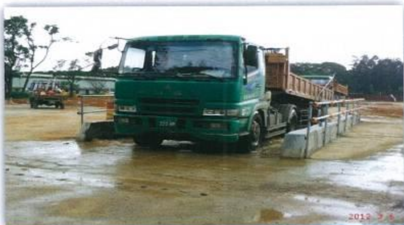
設置洗車設備清洗車輛輪胎
