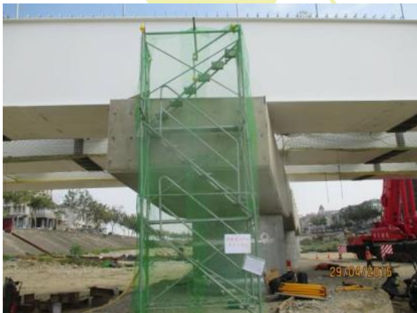
使用CNS4750搭設上下設備
