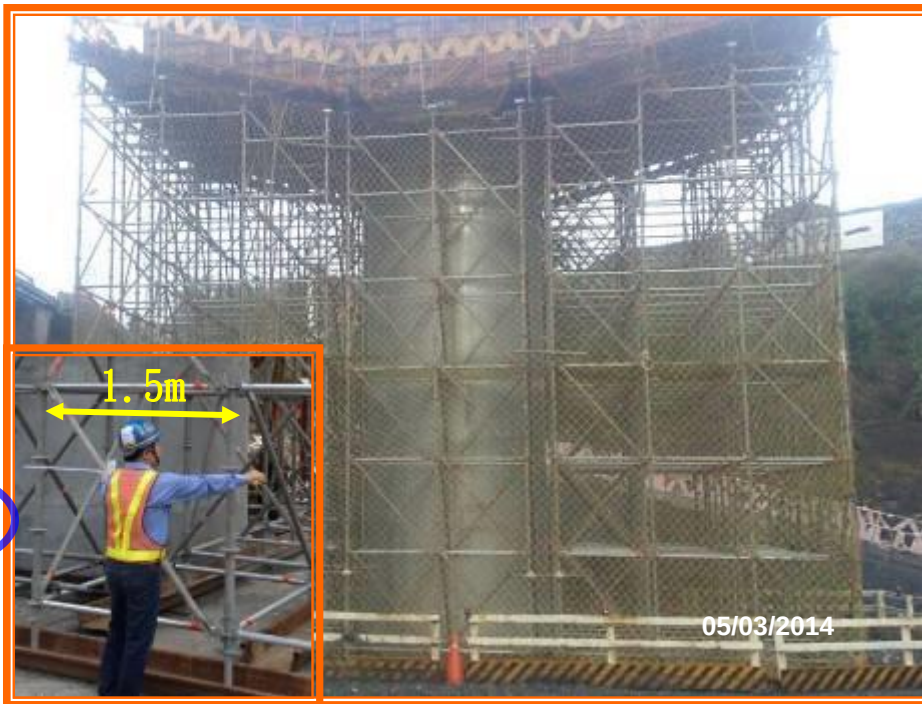
按圖查核支撐系統尺寸、位置 確認與圖說相符 保障施工人員安全
