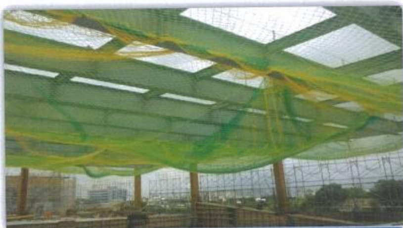
鋼構安全網及防護措施
