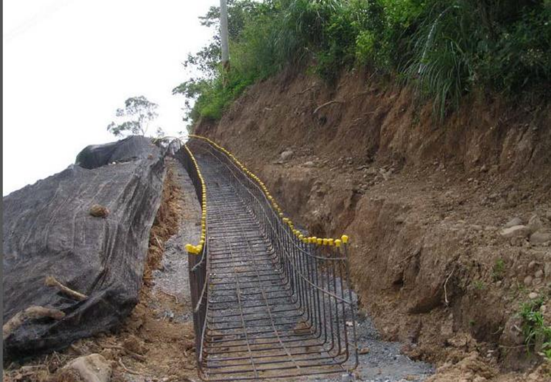
臺3線96K+400- 98K+800苗栗三灣鄉外環道路工程
