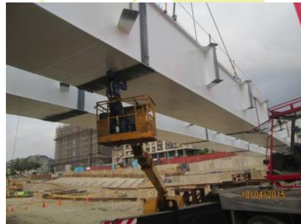
使用高空作業車確實鉤掛安全帶
