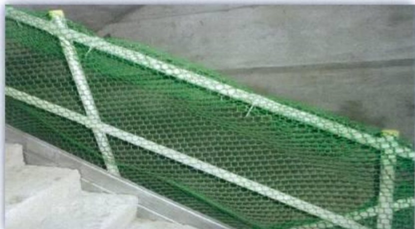
樓梯安全護欄及端部加護套
