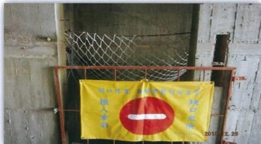
電梯開口加設護欄(含上鎖裝置)
