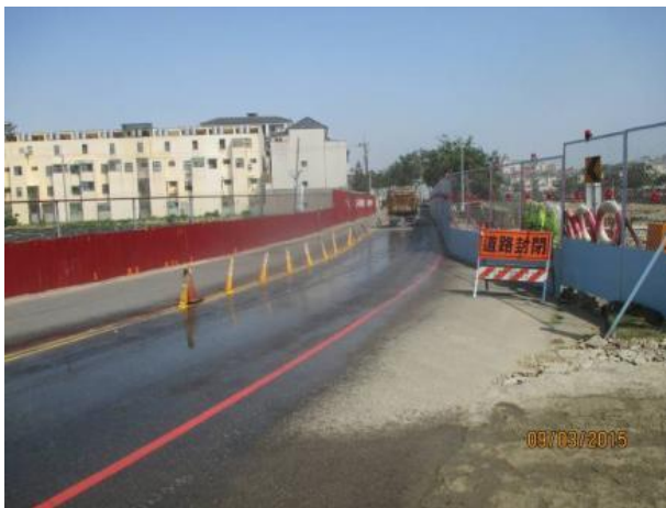
工區外車道路面清洗
