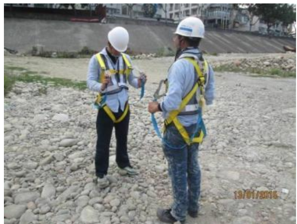
高度超過2m以上作業 確實配戴安全配備
