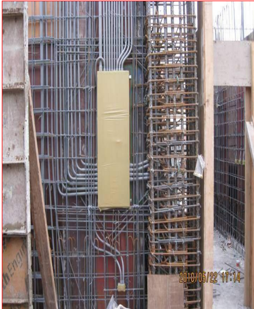
配電箱水電配管
