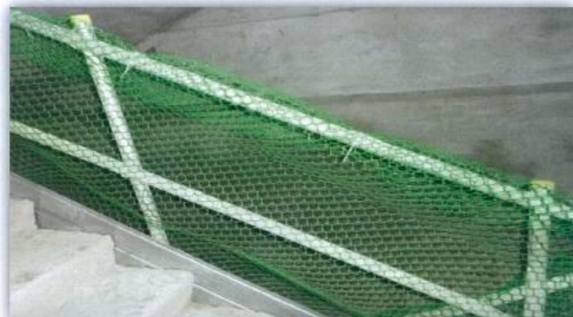
樓梯安全護欄及端部加護套
