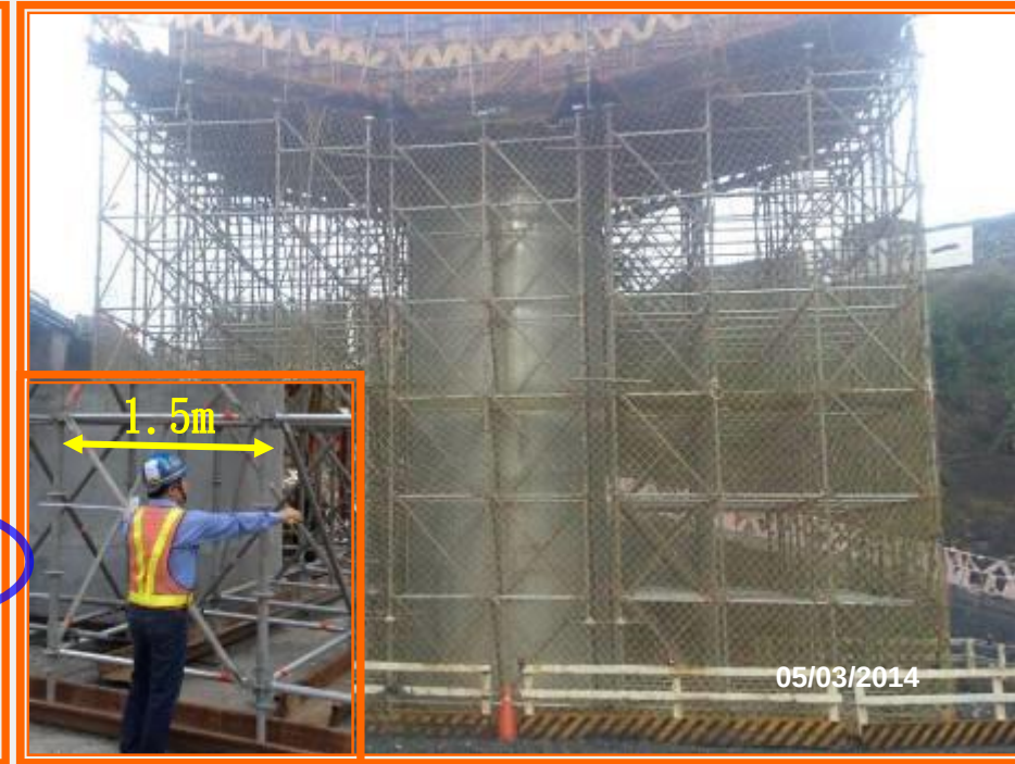
按圖查核支撐系統尺寸、位置 確認與圖說相符 保障施工人員安全
