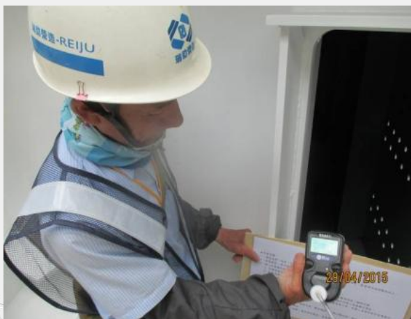
施工人員進入鋼箱梁內施做前， 偵測氧氣濃度達18%以上
