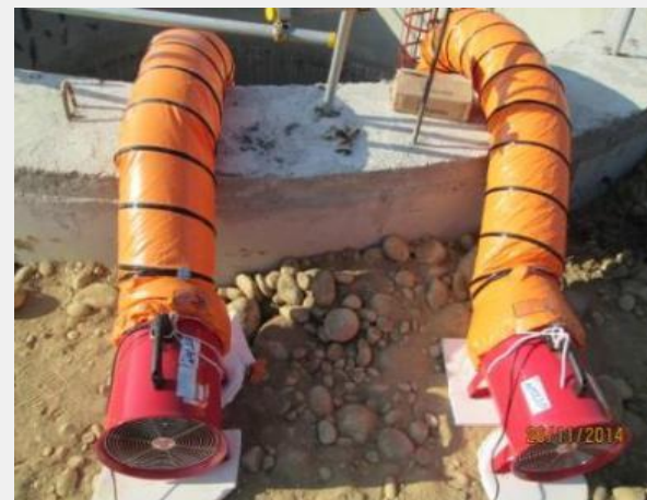
局限空間作業前設置排氣設備
