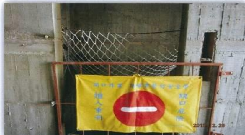
電梯開口加設護欄(含上鎖裝置)
