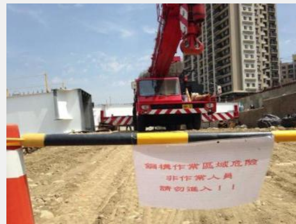
施工區域、以警示錐及拉 桿防止非施工人員進入
