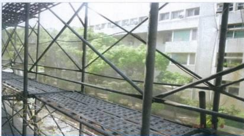
鷹架交叉水平拉桿及踏板
