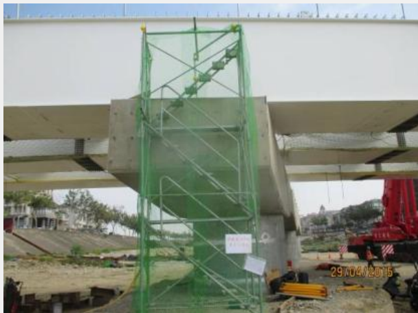
使用CNS4750搭設上下設備
