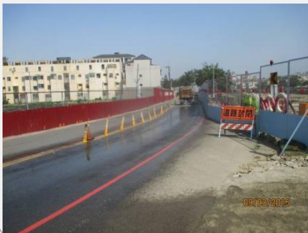
工區外車道路面清洗
