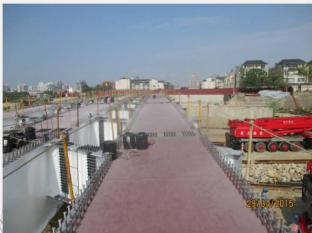
鋼橋檯面拉設安全母索
