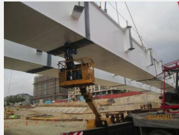
使用高空作業車確實鉤掛安全帶
