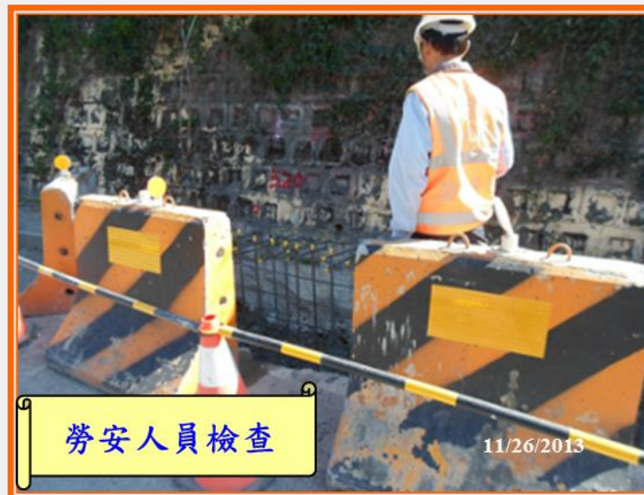
設置鋼筋帽套設施
