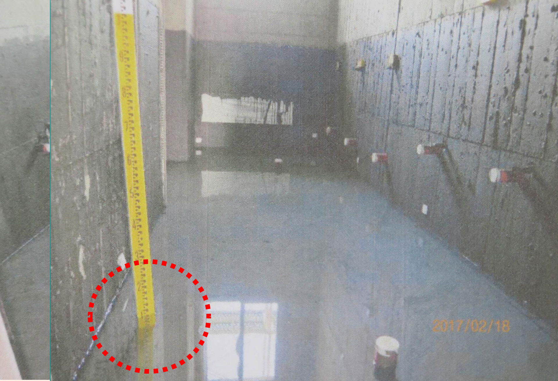
2. 地坪防水層完成後 - 未試水
