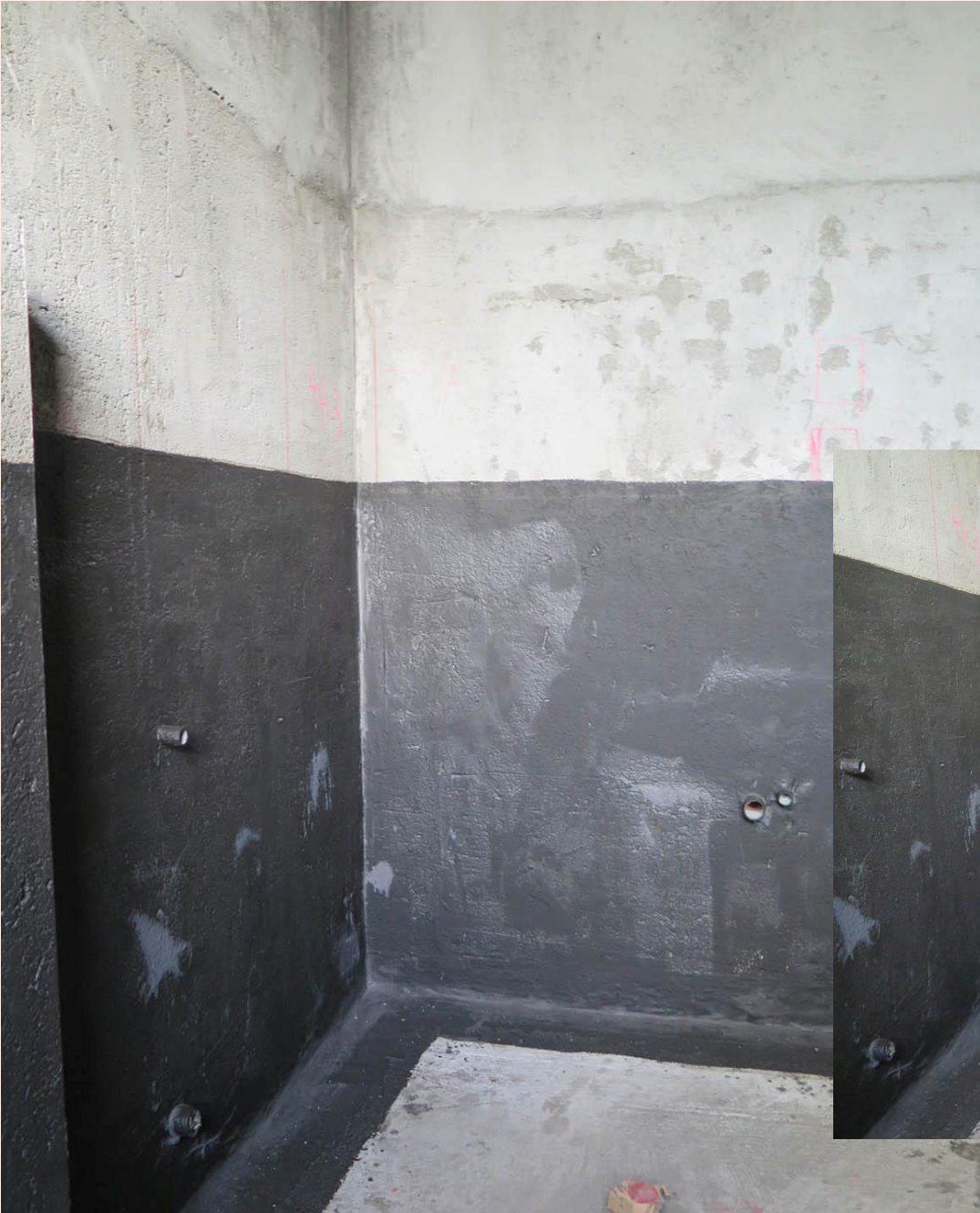
3. 地坪與牆面未施作倒角另防水膜無法確認厚度
