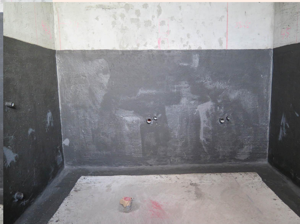
3. 地坪與牆面未施作倒角另防水膜無法確認厚度
