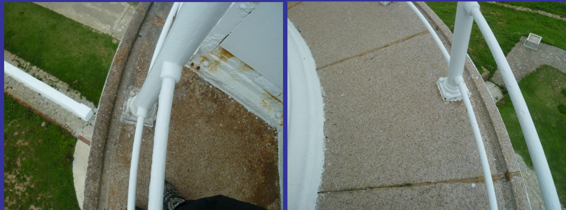
◆東莒燈塔之平台排水淺溝
