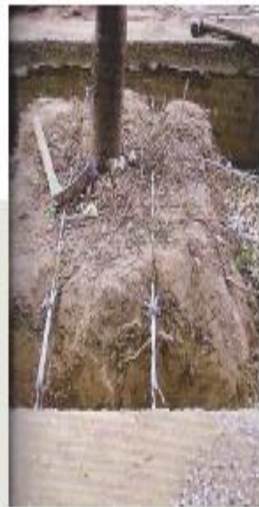
鋼索地盤式支架示意圖
