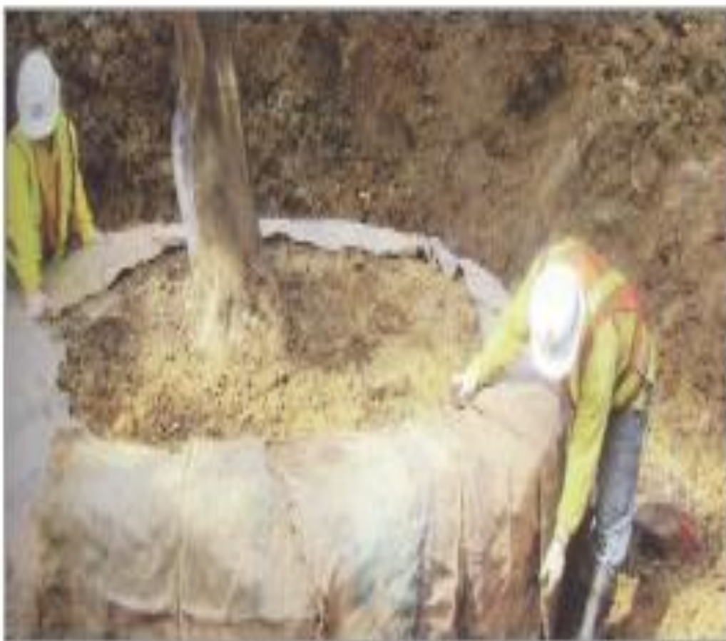
【植栽移植工法－根系土球斷根包覆作業】
