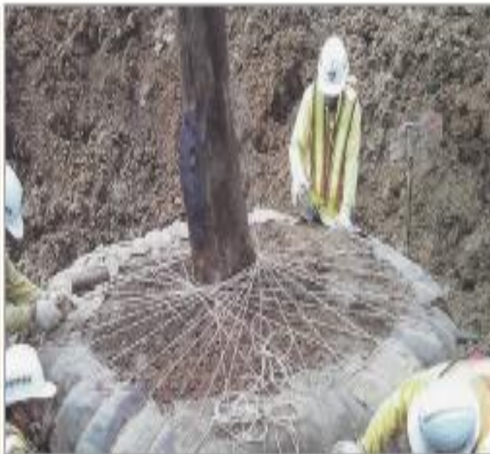
【植栽移植工法－根系土球斷根包覆作業】
