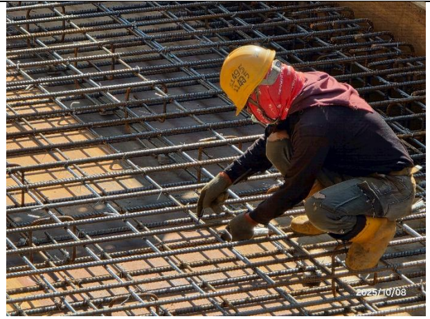
雨水箱涵頂版鋼筋綁紮
