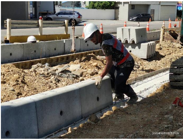
道路復舊-路緣石施作
