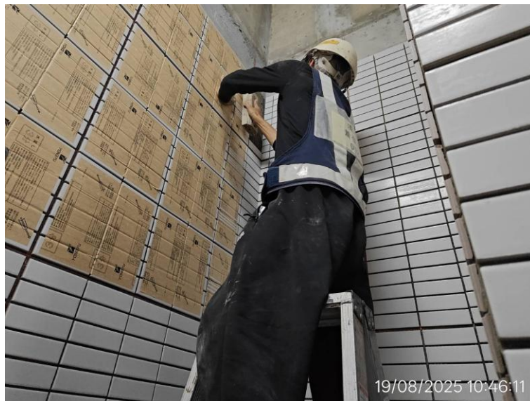
G15a(原 G31)車站出入口三樓壁磚及地磚鋪設
