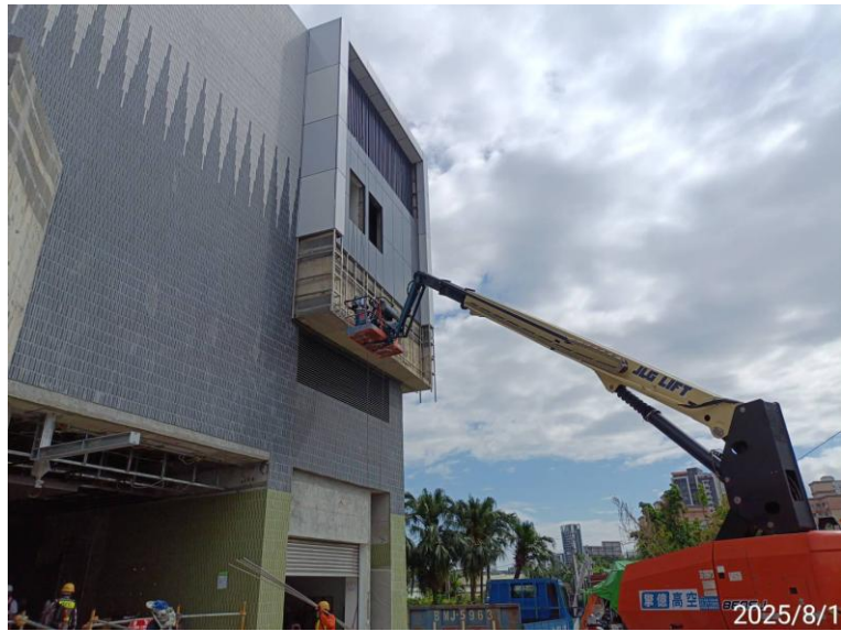
G13 車站出入口鋁帷幕及雨遮施作
