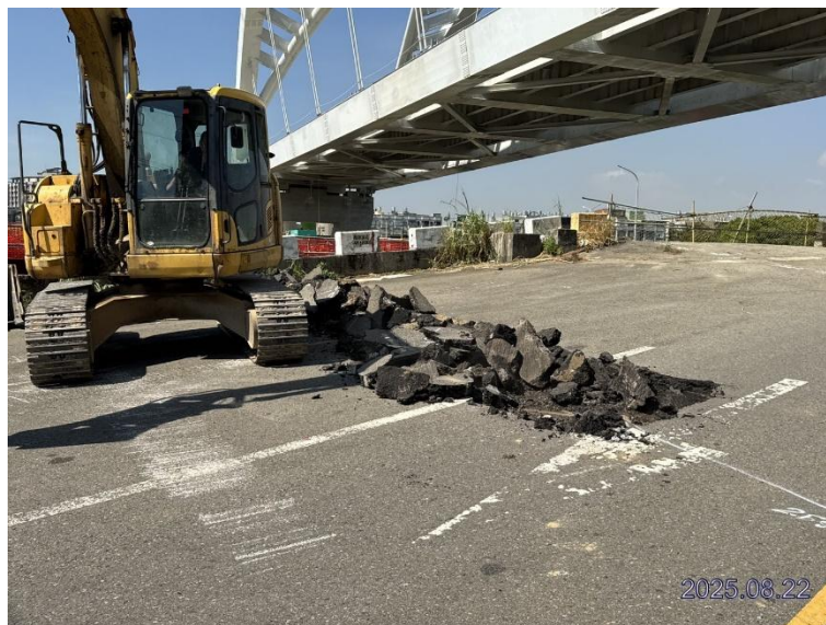
崁下橋吊裝空間破除及整地
