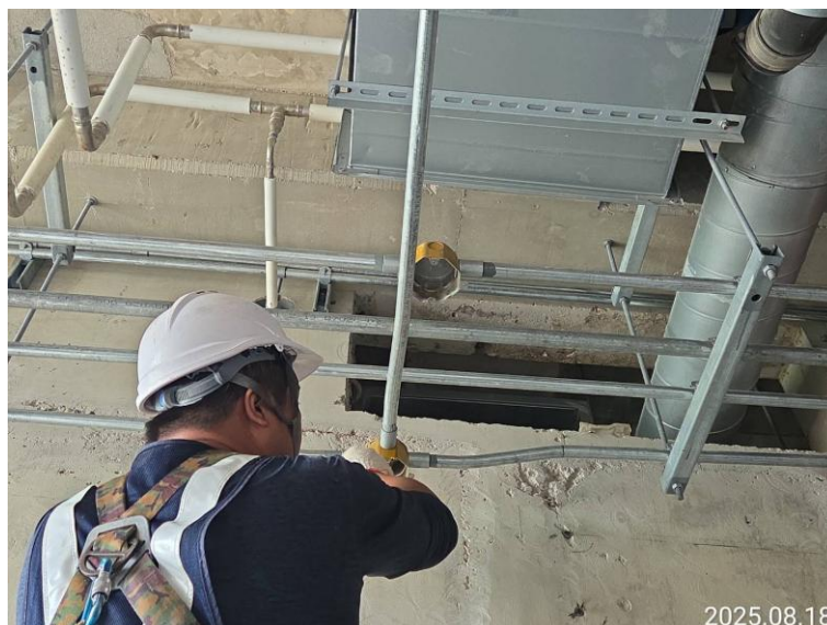
G15b(原 G32)車站 4F 走道電氣配管
