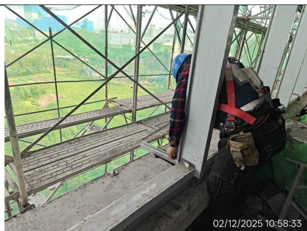
G15(原 G14)車站出入口二樓玻璃帷幕骨架施作
