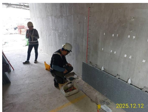
G15b(原 G32)車站出入口一樓石材壁磚鋪貼安裝
