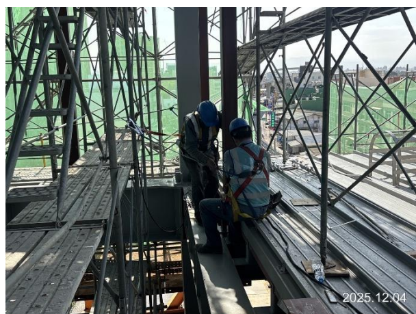
G15a(原 G31)車站站體抗風梁柱施作
