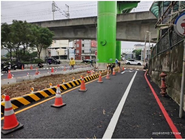
道路復舊-蘆興街反光導標及導桿安裝
