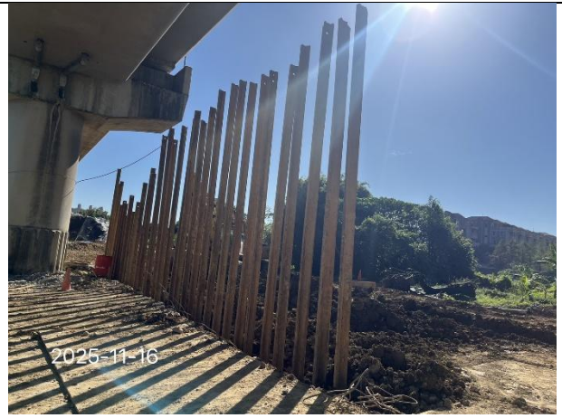
雨水箱涵鋼軌樁打設
