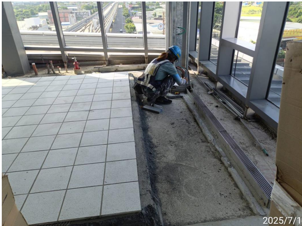
G13 車站站體穿越層不鏽鋼截水溝安裝
