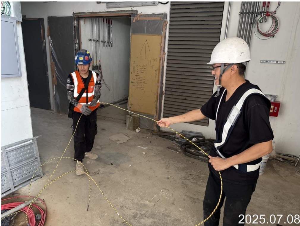
G15a(原 G31)車站 3F 電信、緊急系統配管
