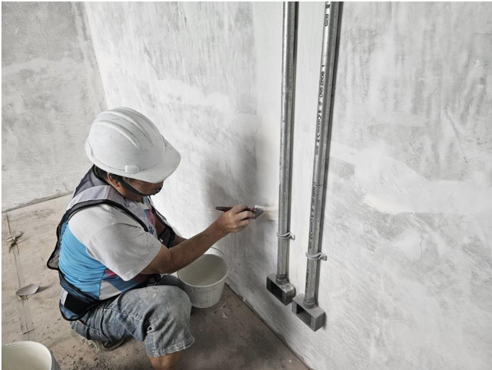
G15(原 G14)車站車站出入口三樓室內油漆
