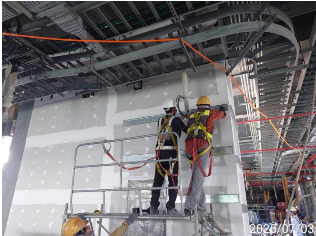
G14(原 G13a)車站站體穿堂層玻璃板骨架安裝
