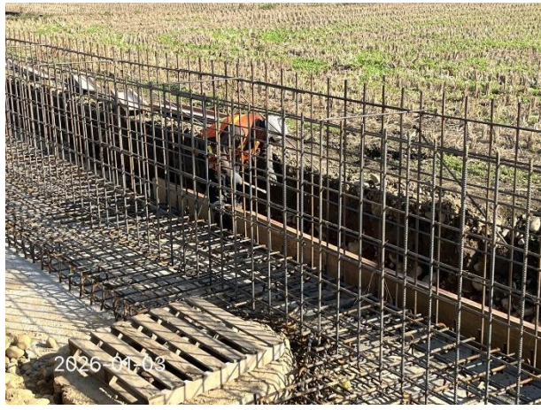
出流管制邊溝牆身模板組立作業
