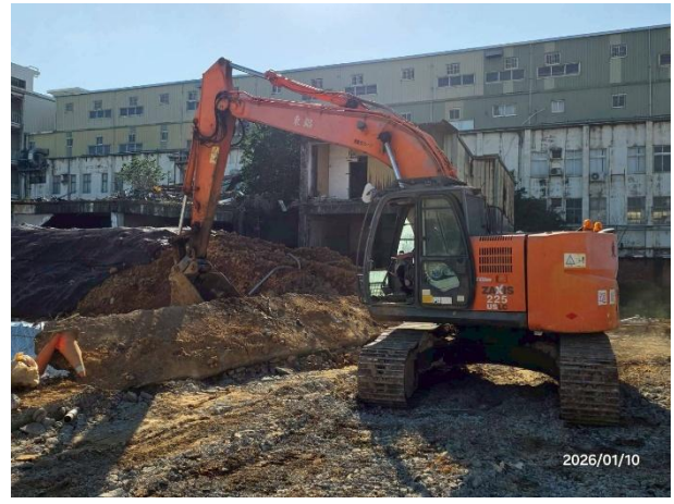
雨水箱涵土方挖掘
