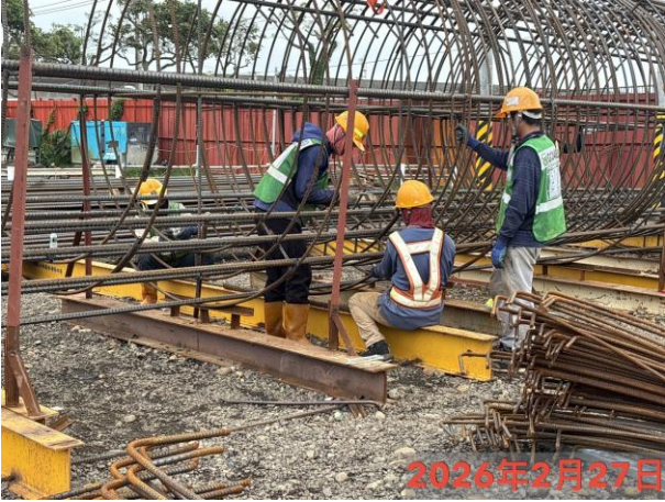
樁帽基礎鋼筋加工作業
