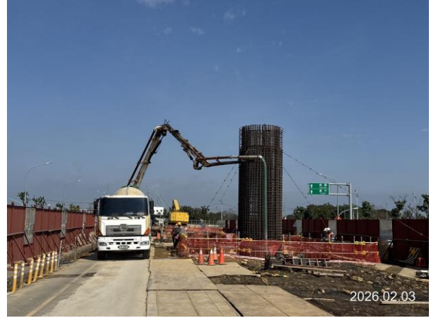
樁帽基礎混凝土澆置
