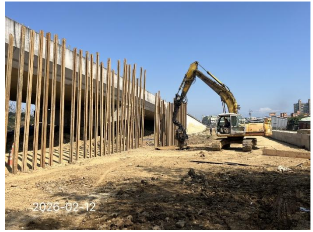
雨水箱涵鋼軌樁打設
