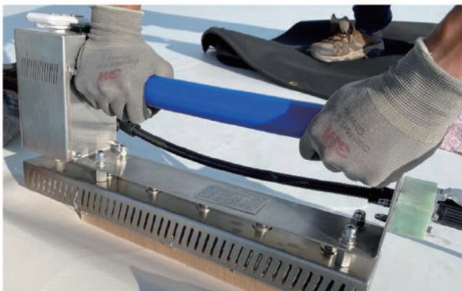
膜材熱熔接
