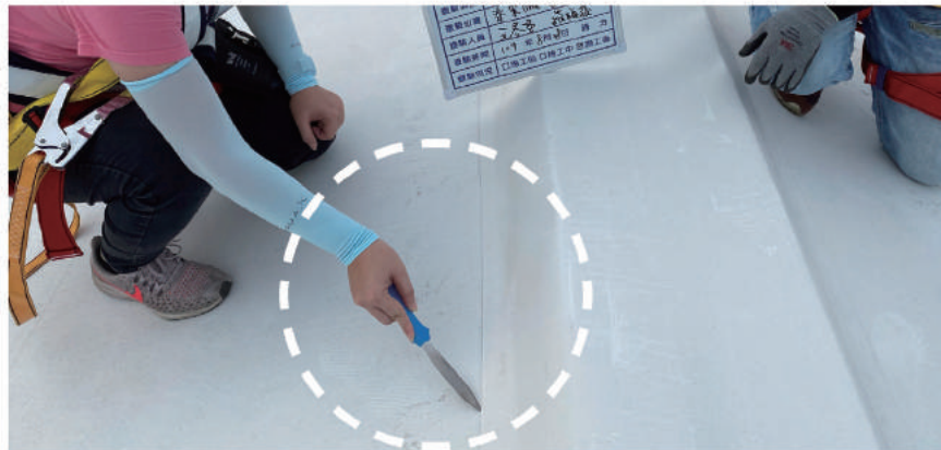
膜材熱熔膜材縫隙測試
