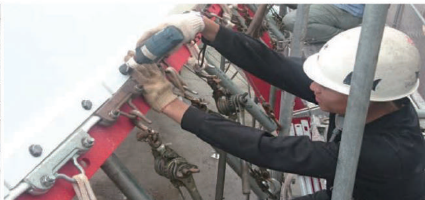
膜結構施工與固定
