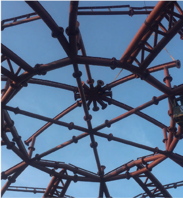
吊裝時需符合高空作業安全守則
