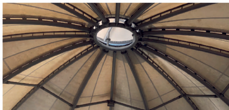
膜材老化應替換
