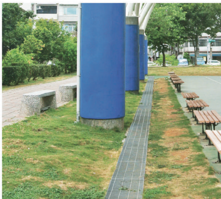
天幕內外需設置排水設施且注意洩水坡度
