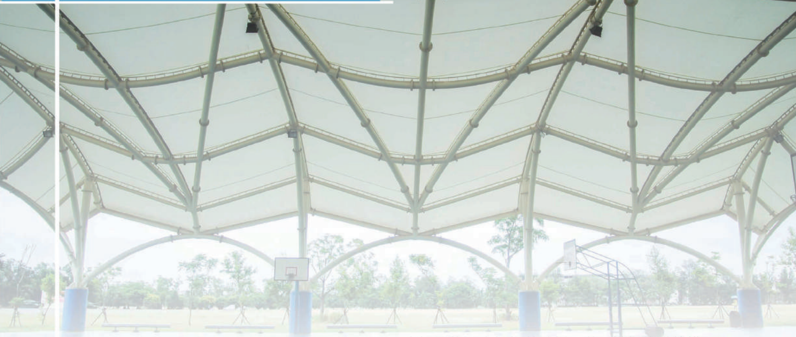
中壢區龍岡大操場藍球場天幕 - 構架式膜結構
