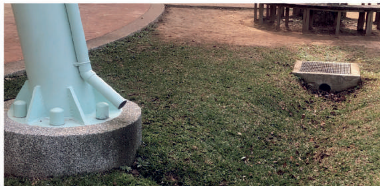
基礎主要支撐上方結構
