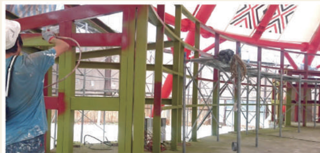
底漆、面漆補漆作業
