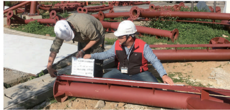
現場檢驗相關尺寸、數量與鋼構編號
