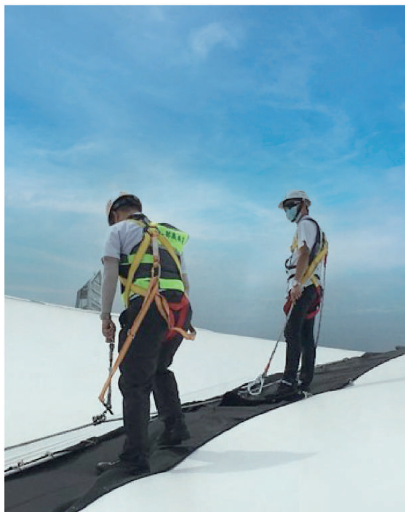
天幕施工應做好高空作業安全
