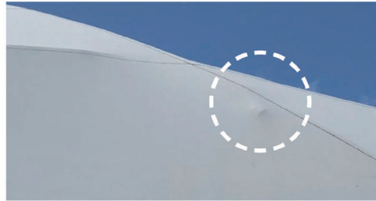
鋼構與薄膜貼合產生銳面
