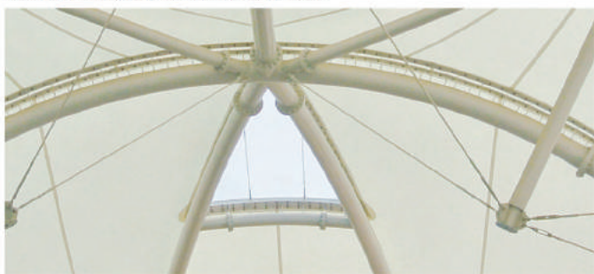
天幕膜上增加透明 ETFE 膜
