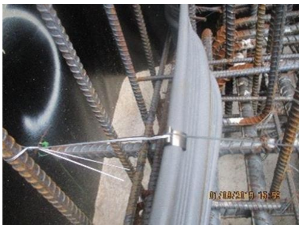
圖1.3：止水帶安裝固定
