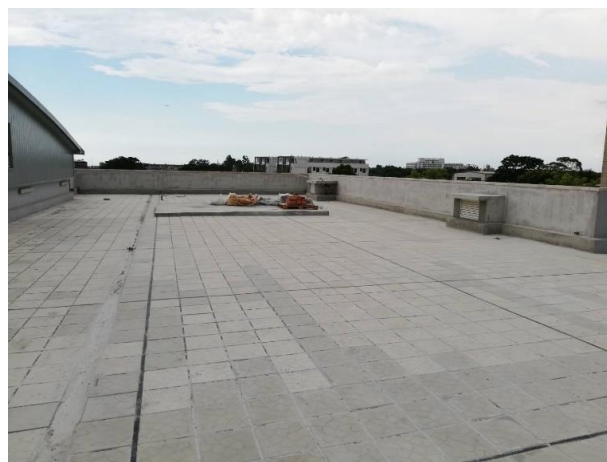
圖 10.4：隔熱磚設置伸縮縫
