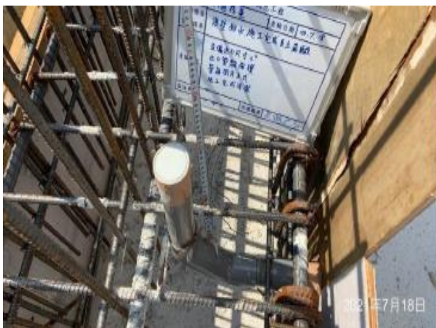
說明 4： 複壁排水管線施作
