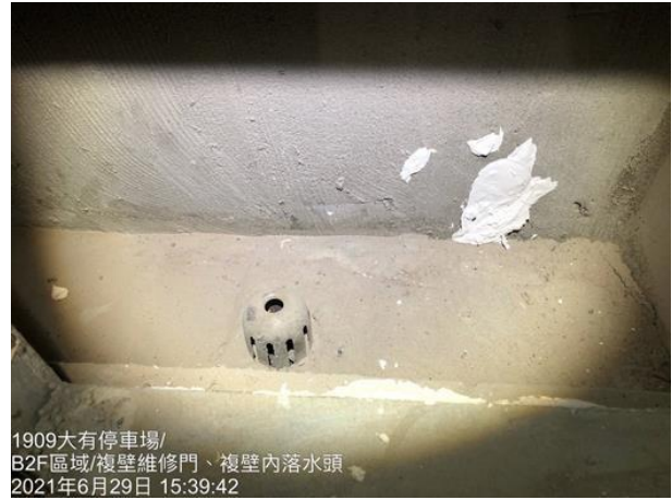
圖 3.2：落水頭留於排水溝中最低處
