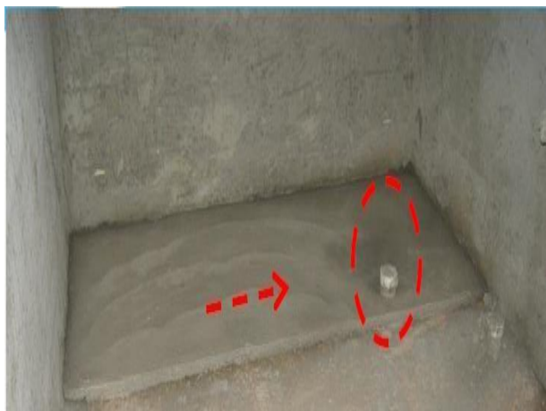
圖 5.1：浴缸底加高，並做洩水坡度
