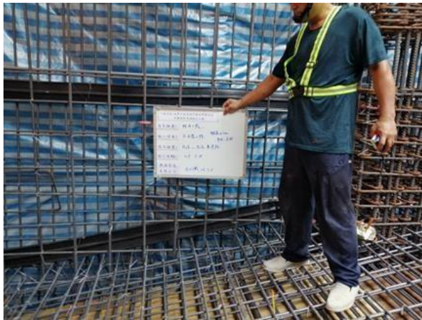
圖 2.8：外牆分次澆築須設止水帶
