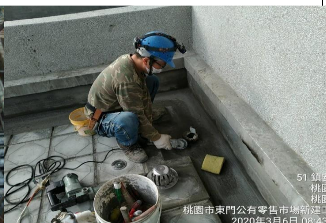
圖 9.2：防水層施作後，以標高器控制 1/200 洩水坡度
