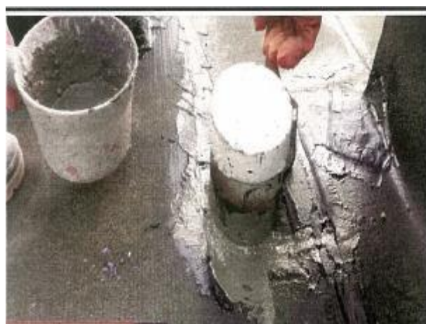
圖 10.6：落水管處防水補強
