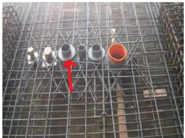
圖 2.7：穿牆管須有止水環
