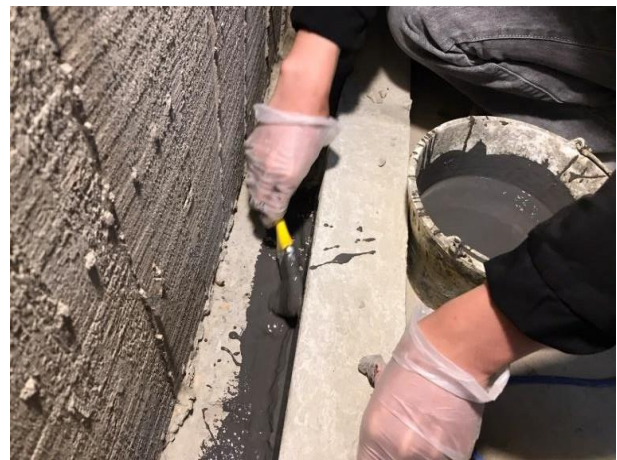
圖 3.4：先 1:2 防水粉刷後再塗防水膠
