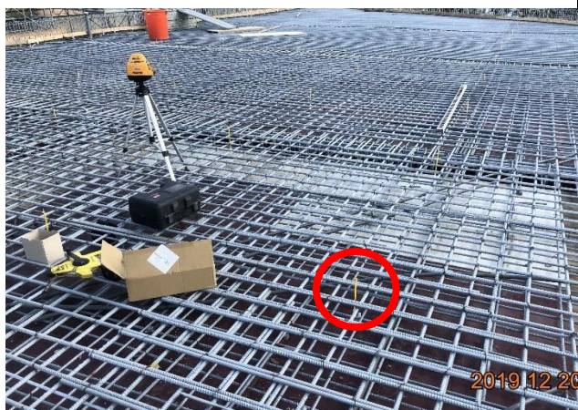
圖 9.1：結構體灌漿前以標高器抓洩水坡度 1/200
