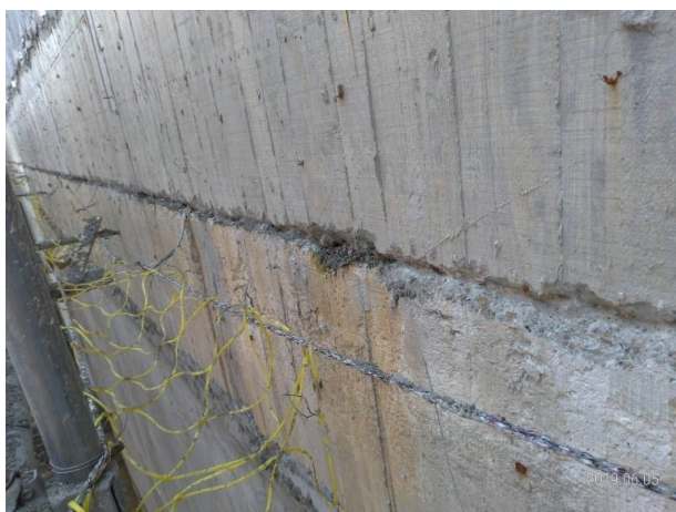
圖7.1：接縫處打V型槽，清除雜物
