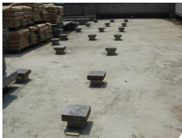
圖 10.10：設備基礎座設置泛水
