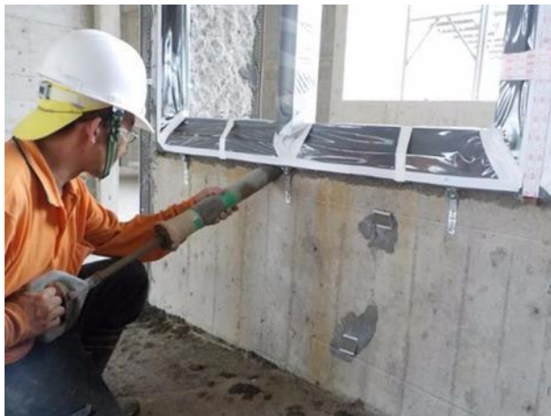
圖 6.1：嵌縫確實填滿框與結構體縫。
