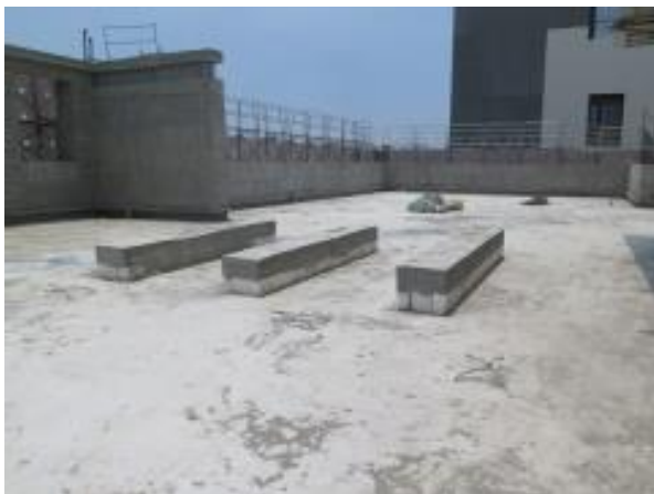
圖 10.11:設備基座泛水
