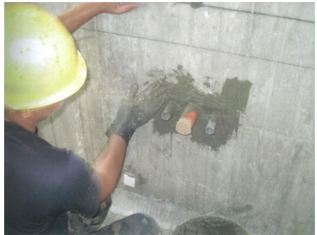
圖 2.5：穿牆管四周以防水材補強
