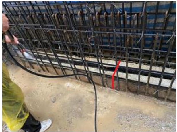
圖 2.9：預留凸 KEY、預埋止水帶
