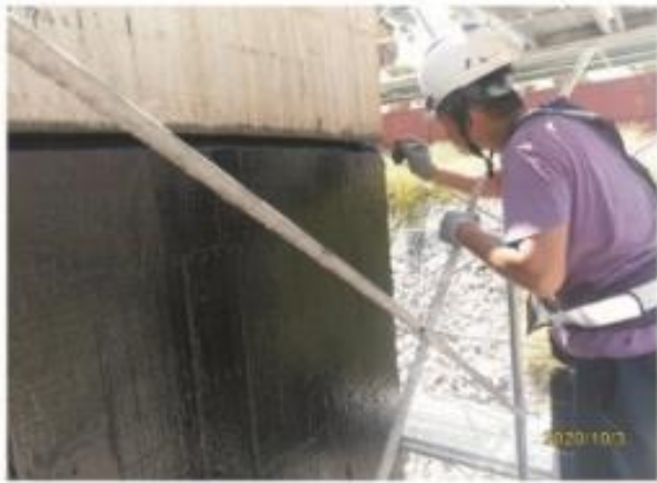
圖 2.4：防水收頭施作
