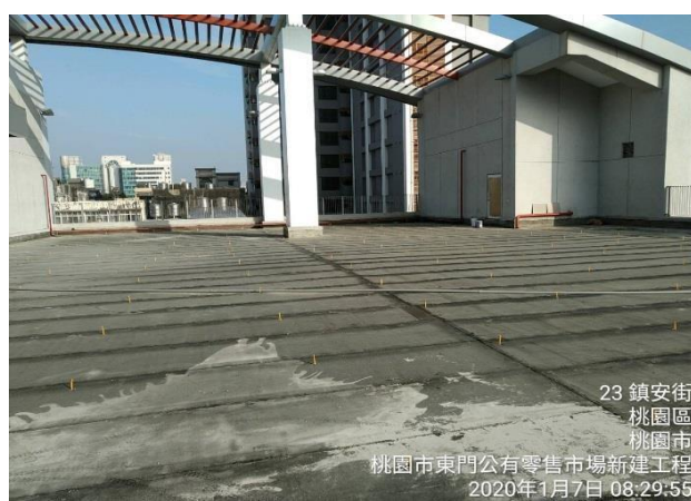
圖 9.2：防水層施作後，以標高器控制 1/200 洩水坡度
