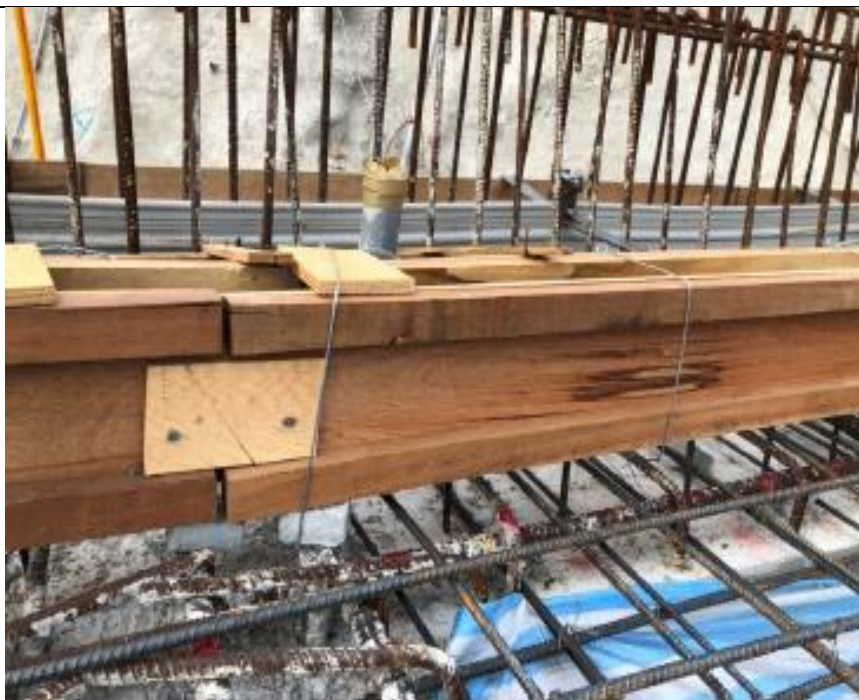
說明 3： 止水墩模板，吊模施作
