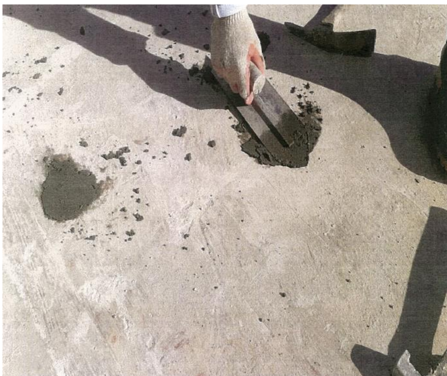
素地整理 -坑洞回填
