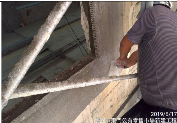
圖 6.3：窗框角隅施作防水抗裂網
