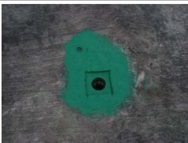
圖 10.7：落水管處防水補強
