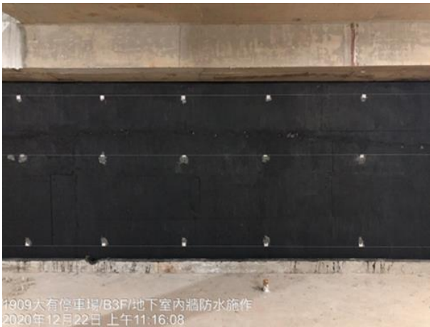
圖 3.5：確認連續壁已止水
