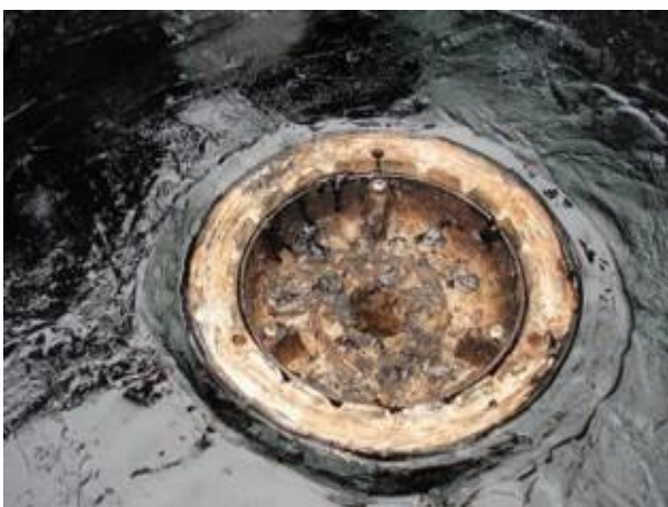
圖8.1：落水頭擴口以利防水層折入
