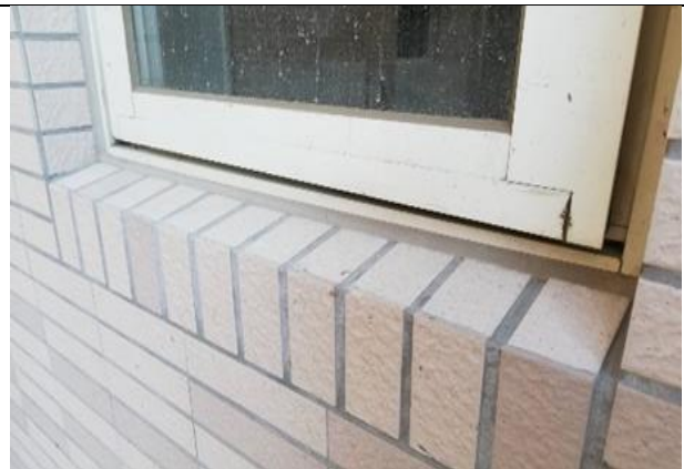
圖 6.4：磁磚黏貼方向與排水方向一致
