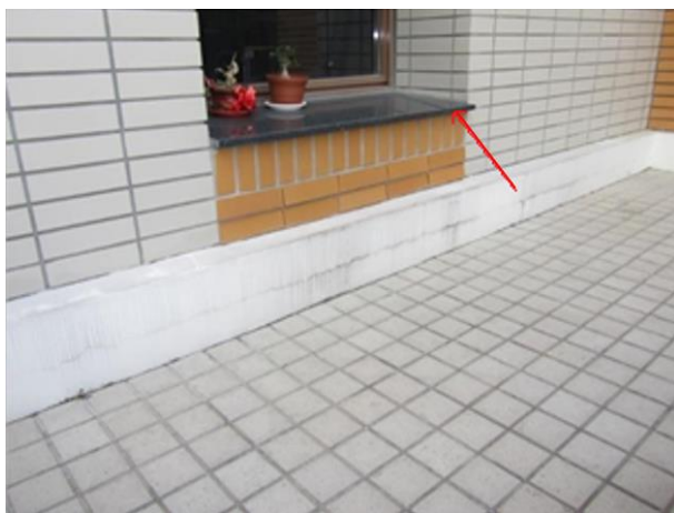
圖 6.7：窗台設置批水板以利排水
