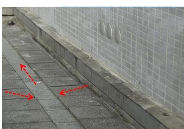
圖 9.4：以水泥砂漿當集水溝表面材料
