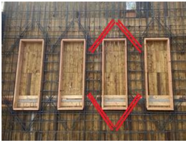
圖 6.5：窗框周遭補強筋綁紮
