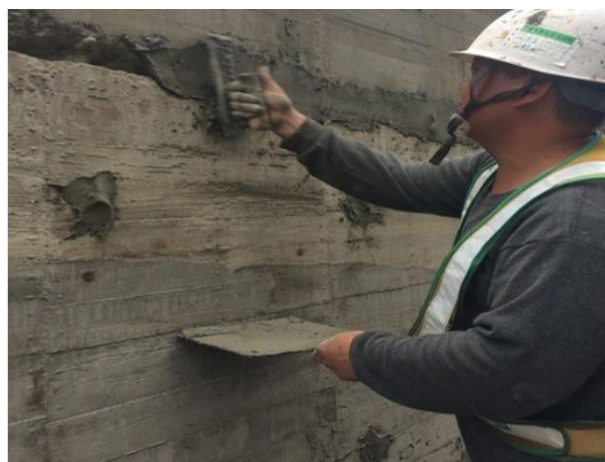
圖 7.2：水泥砂漿填補
