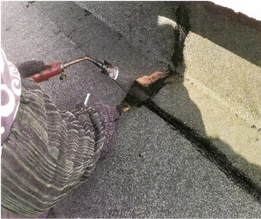
搭接封膠(含壁體 L 型鋁製壓條)
