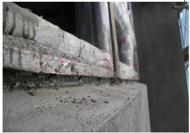
圖 6.2：窗框底緣抓洩水坡度粉刷
