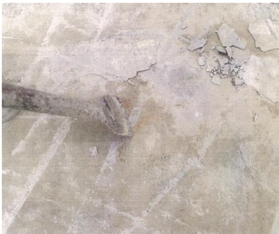
素地整理 -土渣整平
