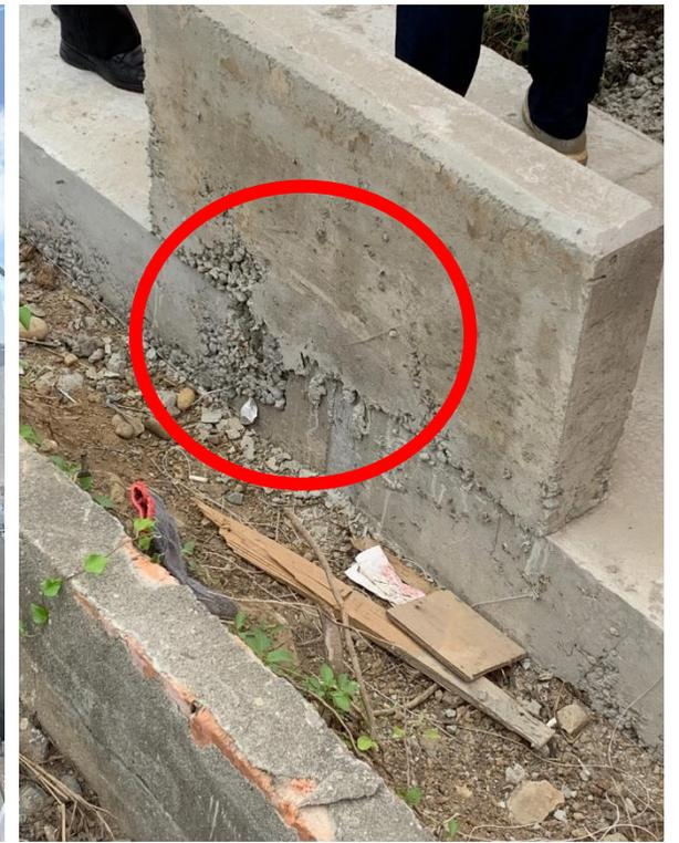
**預防方法：**使用坍度足夠之混凝土，卸料時盡量接近澆置面( $\leq 1.5\text{m}$ )，避免粒料析離，並確實搗實(必要時分層澆置搗實)。
