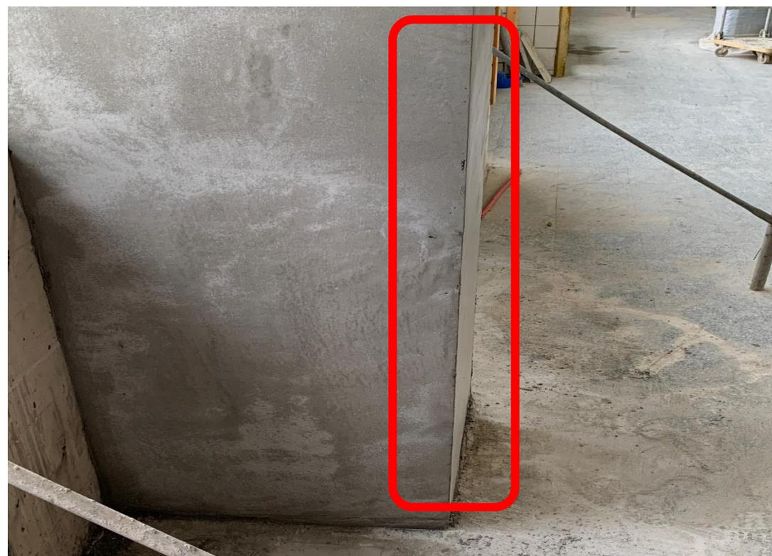
預防方法：設計及施工時應考量安全性及後續維護，混凝土構造物陽角**施作倒角**可避免邊角破損情形及提高安全性。
