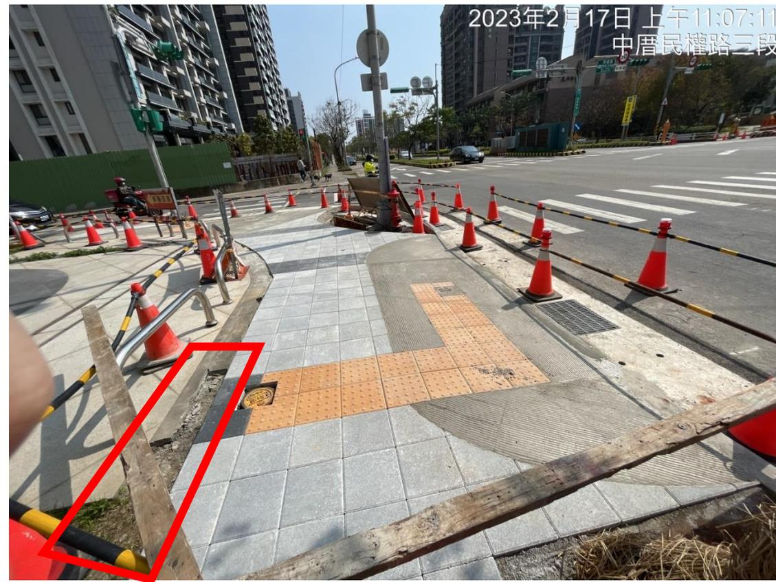
預防方法：混凝土澆置或鋪磚需預留吊裝螺栓位置避免覆蓋。
