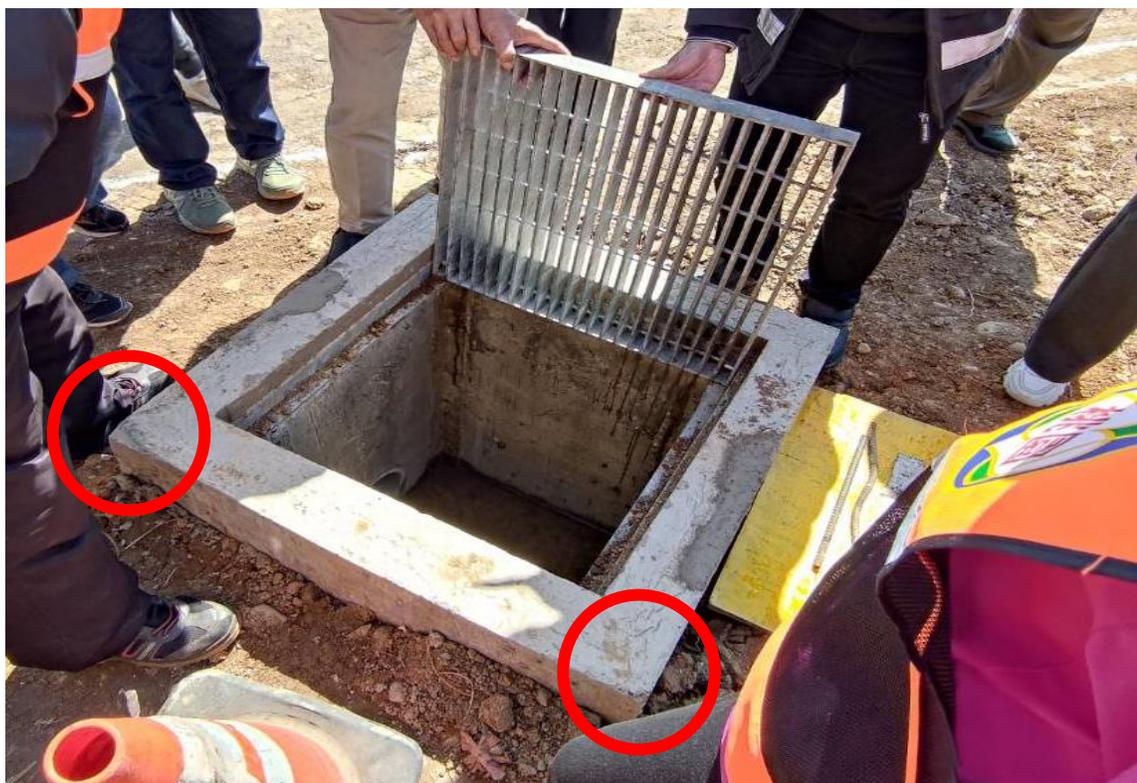
預拌混凝土**未施作倒角**，容易導致兒童受傷情形。
