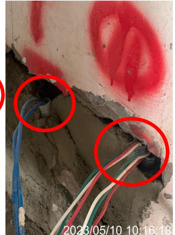
預防方法：電線配管接頭按規定施作喇叭口。
