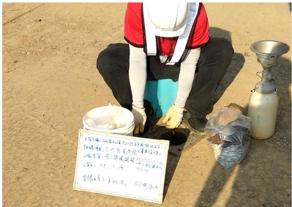
圖 6-12 滾壓完成後工地密度試驗
