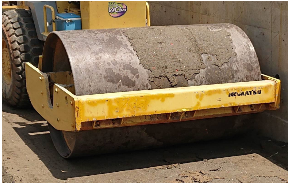
圖 6-10 滾壓作業將混合料水分再次擠出
