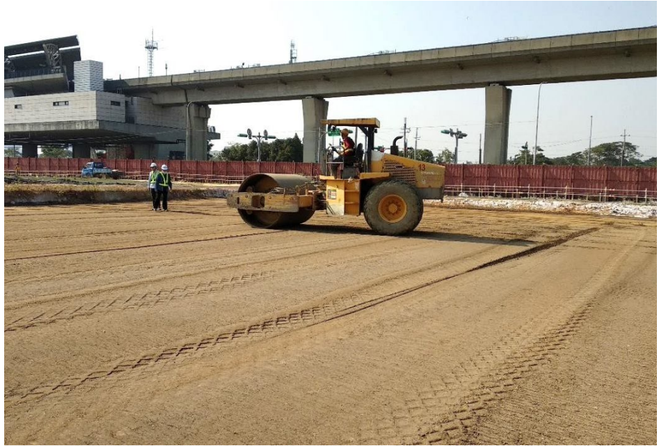
圖 6-11 滾壓與加強拌和作業分階段同時進行
