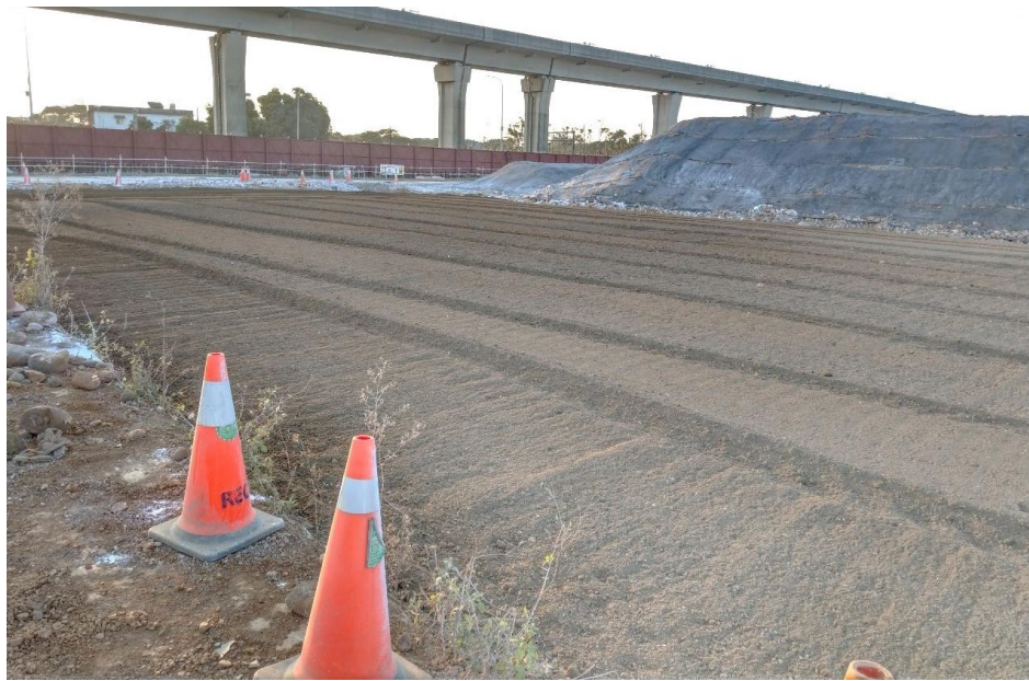
圖 6-9 隔夜養治使混合料減水作用充分反應
