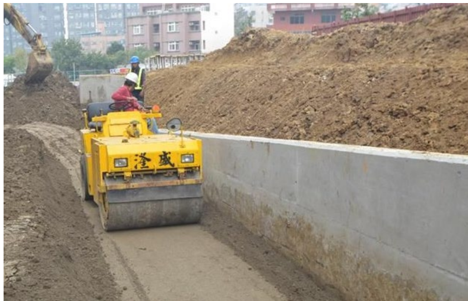
圖 6-13 混合料運回工區進行填築滾壓
