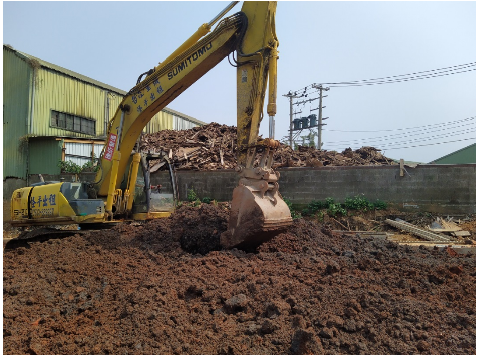
圖 6-7 挖土機初步上下翻拌
