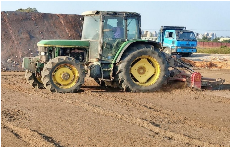
圖 6-8 農耕機完整拌和
