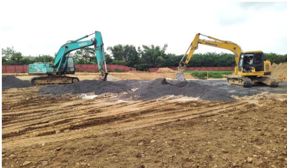
圖 6-6 鋪築焚化再生粒料
