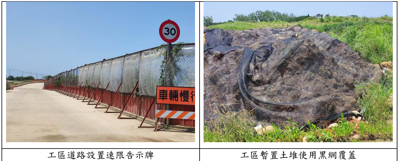
圖 2、施工階段生態友善措施執行情形
