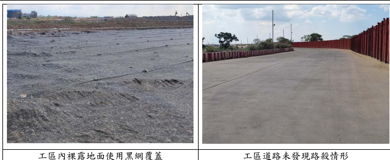
圖 2、施工階段生態友善措施執行情形
