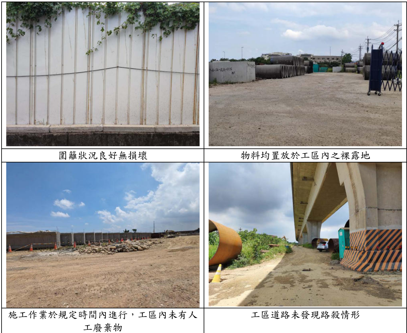
圖 2、施工階段生態友善措施執行情形
