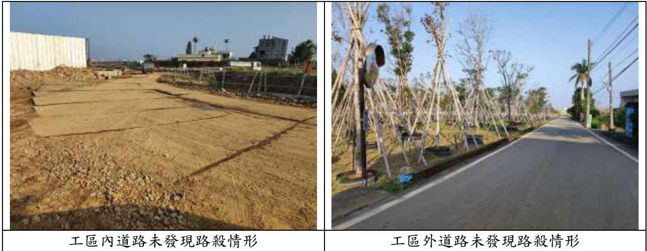
圖 2、施工階段生態友善措施執行情形
