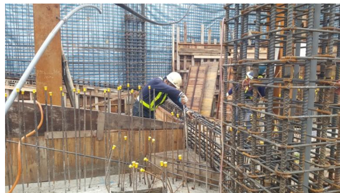
107. 01. 20 實拍工程施作過程
