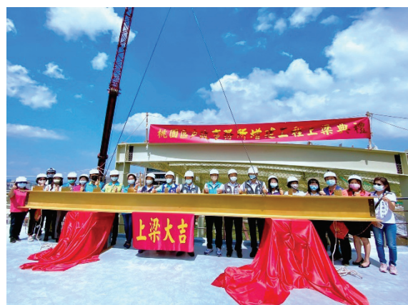
【桃園區戶政事務所增建工程上梁典禮】
