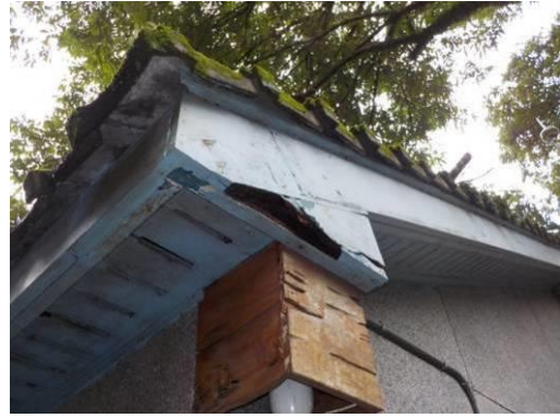
屋簷處木材腐朽劣化
