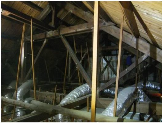
照片 5-1-5 偶柱式桁架
