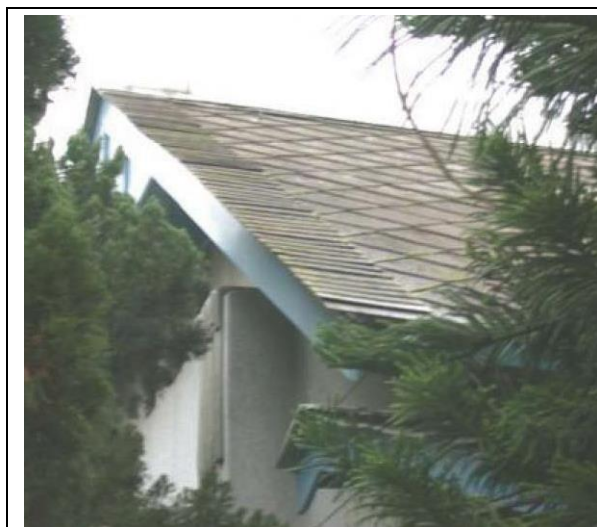
照片 3-2-6-A 民國 93 年登錄歷史建築時之照片，屋瓦似為平板石棉瓦斜交鋪葺。
