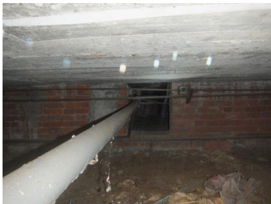
連續布基礎為磚造且設有通氣口
