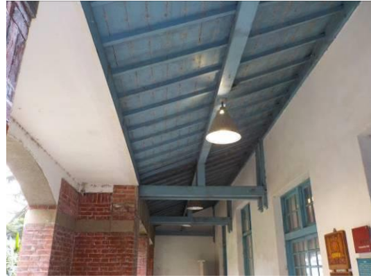
照片 5-1-8 東側簷廊
