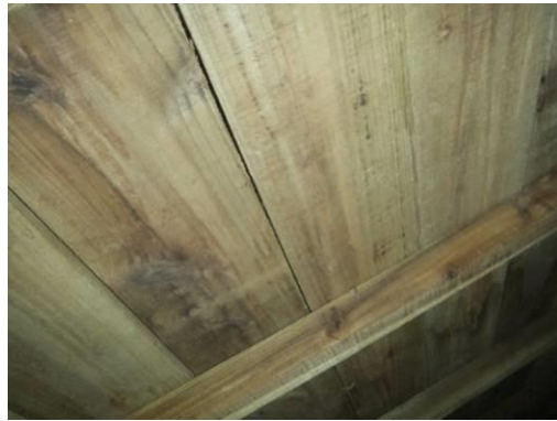
屋面板修復時使用柳杉防腐處理材，無生物及微生物性危害發生
