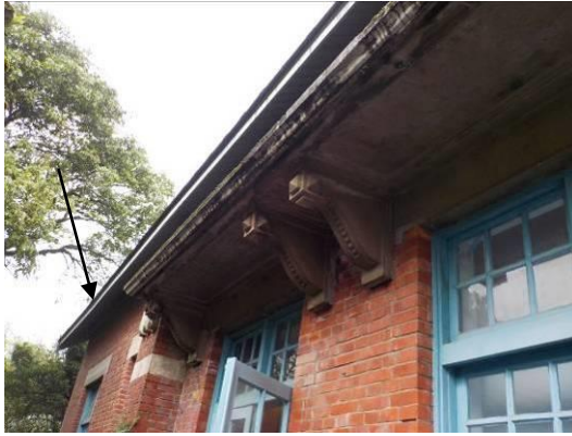
照片 5-1-7 窗戶為平拱，設置楣樑
