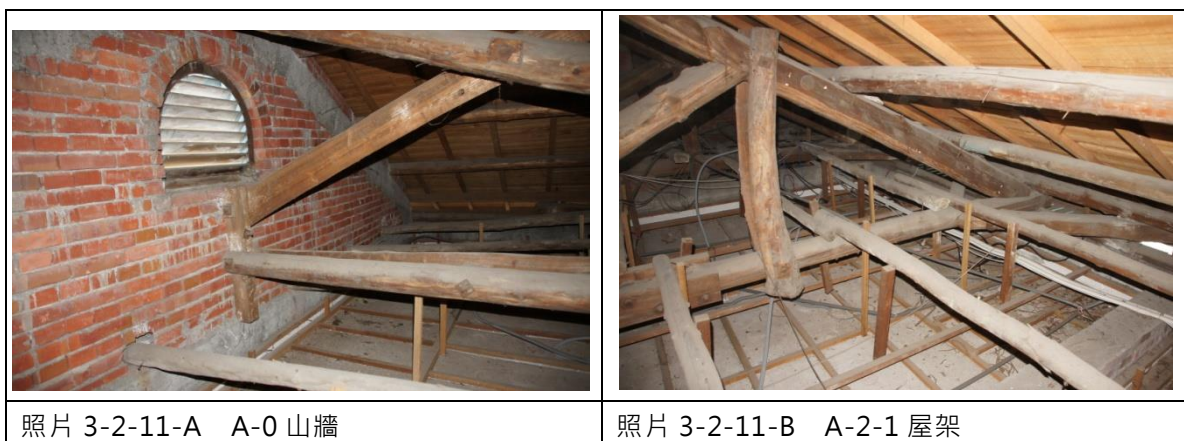
照片 3-2-11 蔣公行館屋架照片
