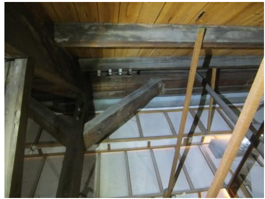
照片 5-1-6 陸樑與敷桁間火打構件
