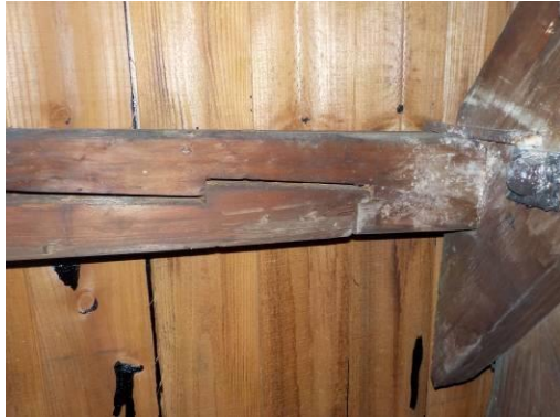
屋水痕及屋面板上瀝青防水工程
