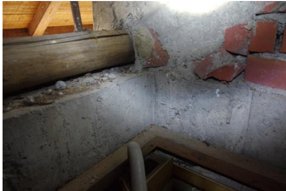
照片 5-2-1 磚造牆頂施作 RC 圈樑
