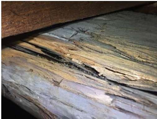
母屋上側有腐朽菌危害
