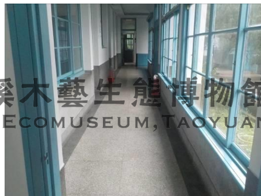
走廊右側牆體量測結果為 10-13，為潮濕狀態
