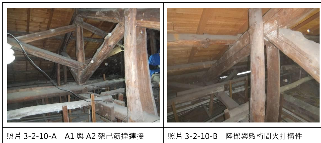
照片 3-2-10 蔣公行館屋架照片
