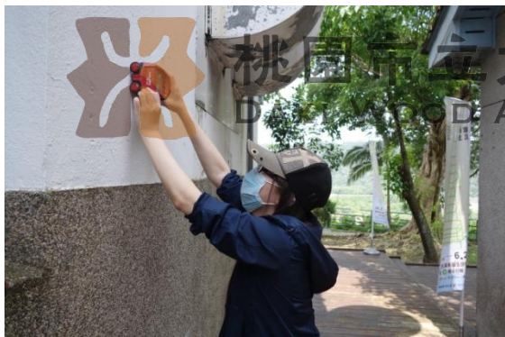
照片 5-2-3 室外牆體之鋼筋檢測
