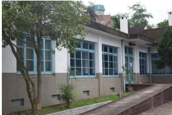
照片 5-2-2 廊道之 RC 平頂及 RC 柱
