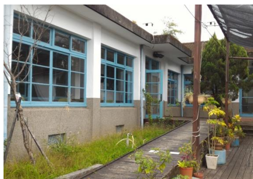
照片 3-2-7-B 走廊為水泥平頂
