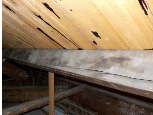
母屋水痕及屋面板上瀝青防水工程
