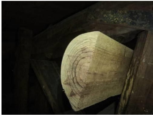
筋違修復時使用柳杉防腐處理材，無生物及微生物性危害發生
