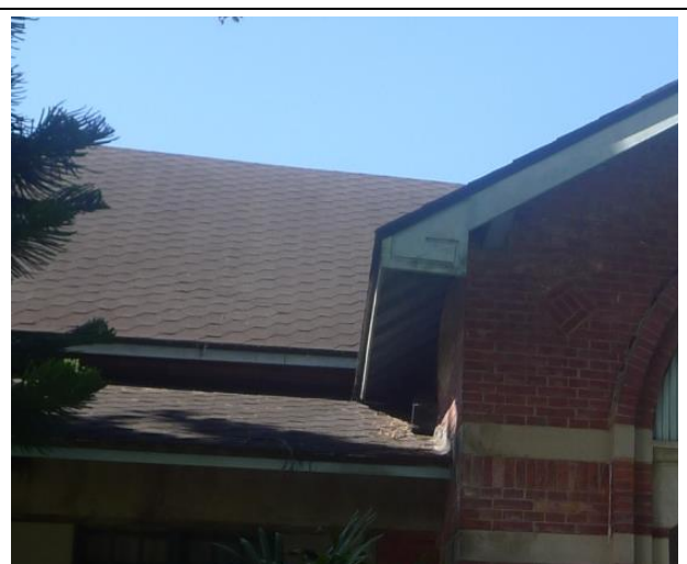
照片 3-2-6-B 成立大溪藝文之家時，屋頂屋瓦改為一般俗稱之可樂瓦。
