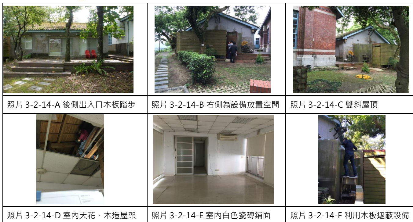
照片 3-2-14 管理室建築式樣照片
