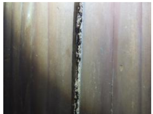
公會堂屋架層第 3 架屋束發現遮蔽管
