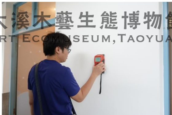
照片 5-2-4 室內牆體之鋼筋檢測
