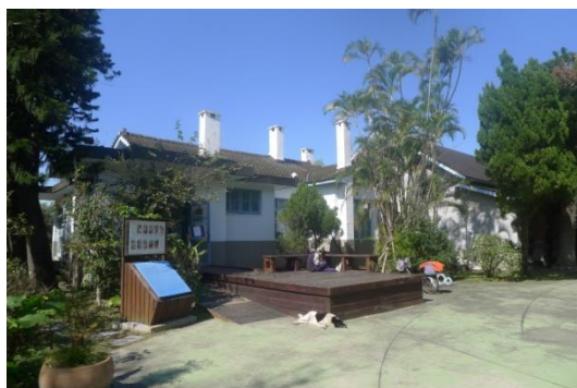
照片 3-2-7-A 雙斜屋頂及多支突出之煙囪
