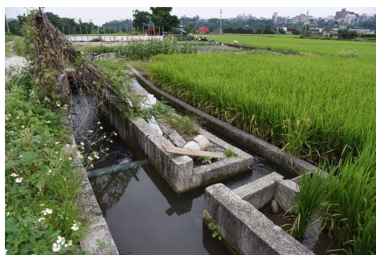
照片 10-17 仙佑福南側分水工
