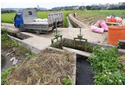
照片 10-16 東西二線分水工
