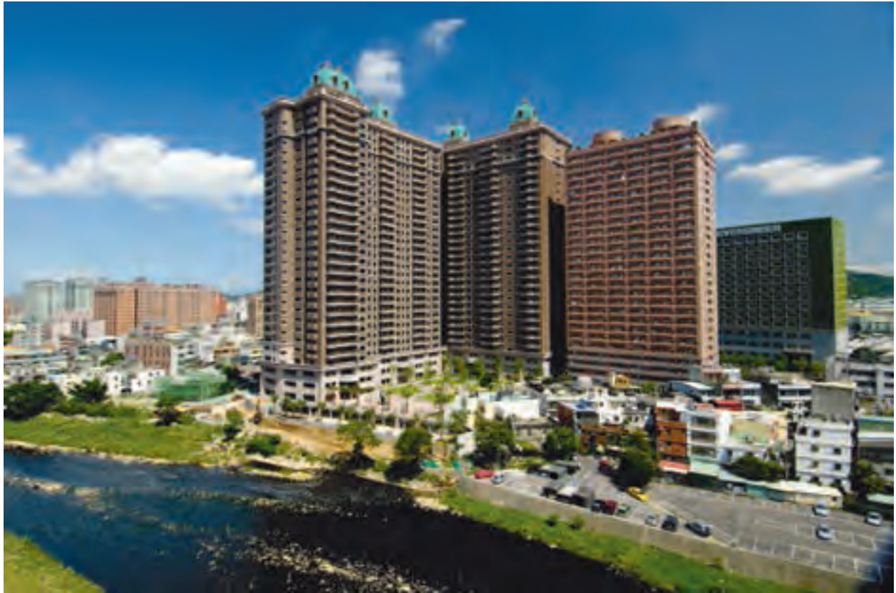
南坎溪岸邊高樓林立
