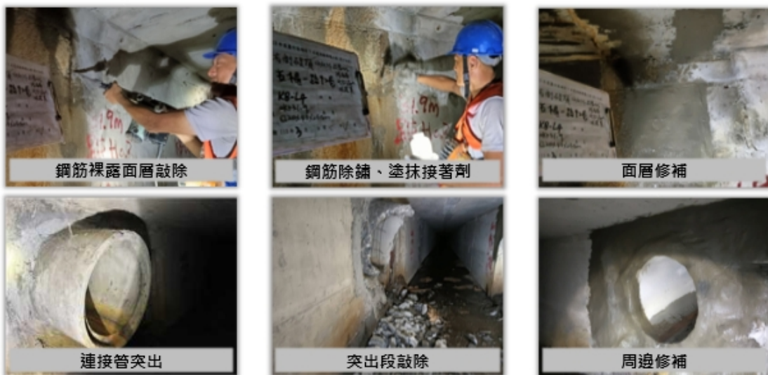
圖2 結構修繕情形
